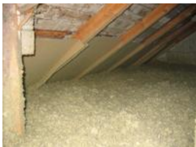
Kuva 3: Puhallusvilla yläpohjassa (Laroc Energia Center 2013)
