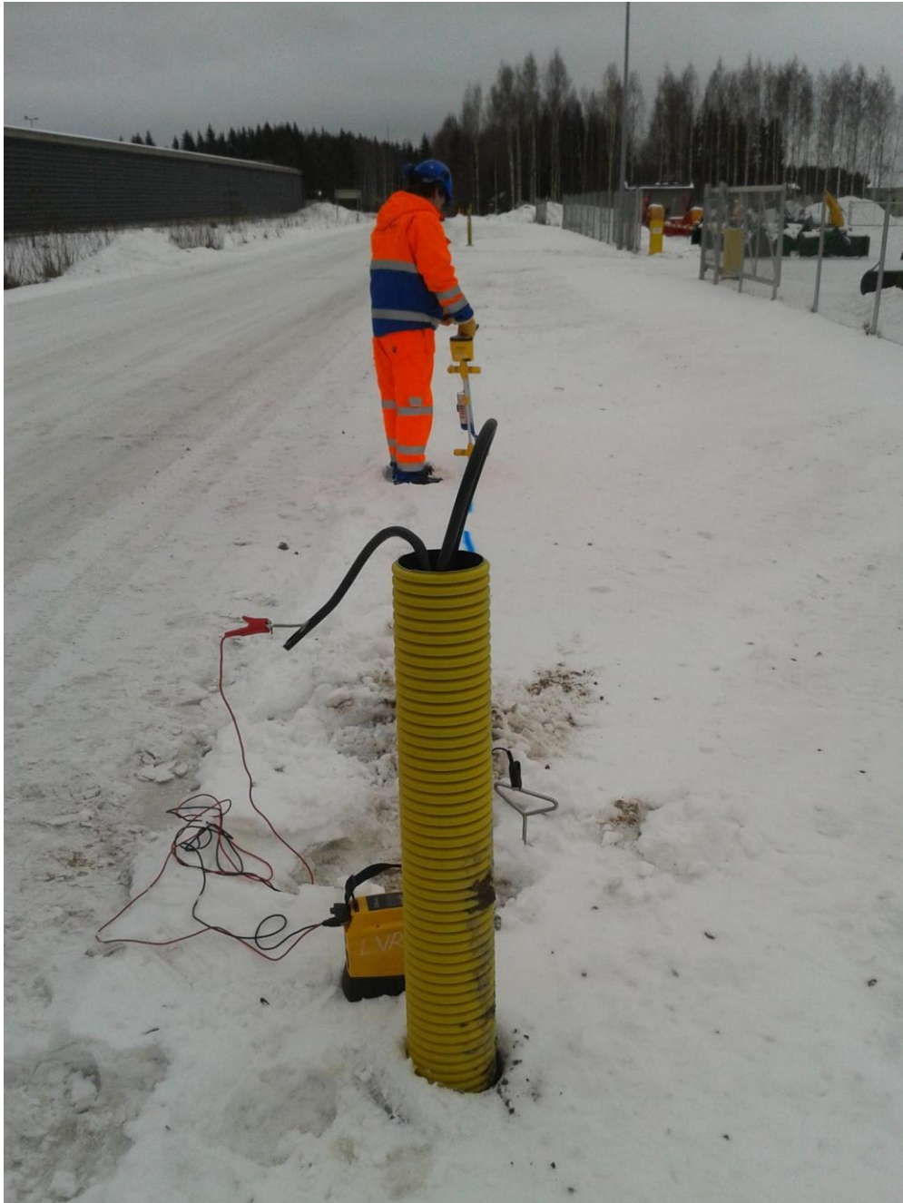
KUVA 8. Kolmas tapa etsiä kaapeleita
