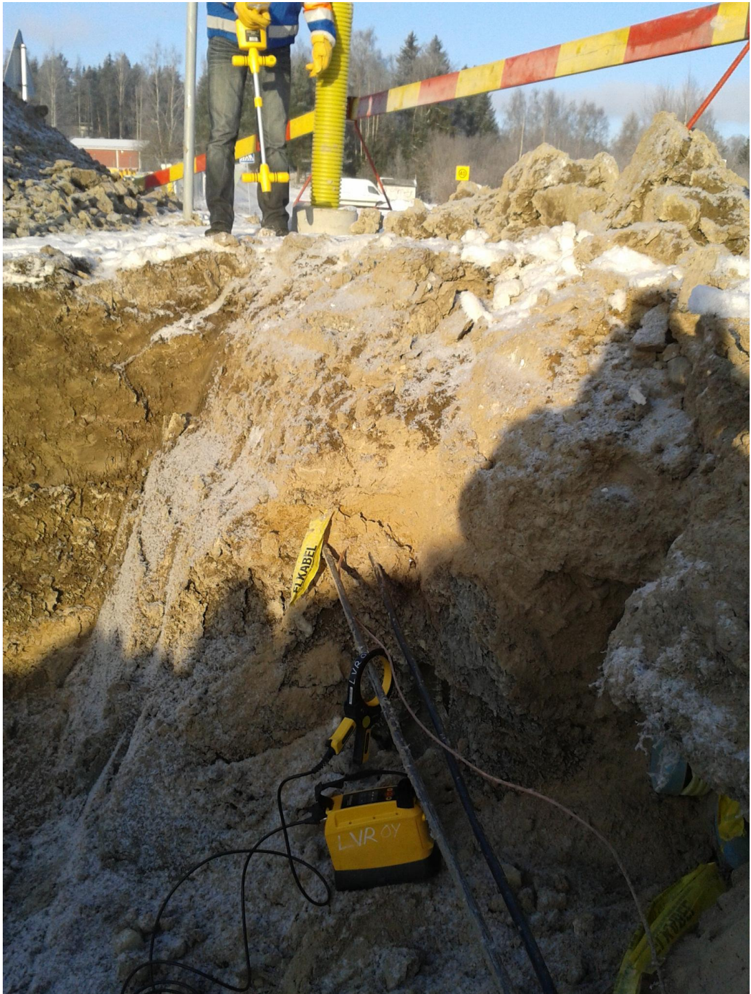
KUVA 7. Toinen tapa etsiä kaapeleita
