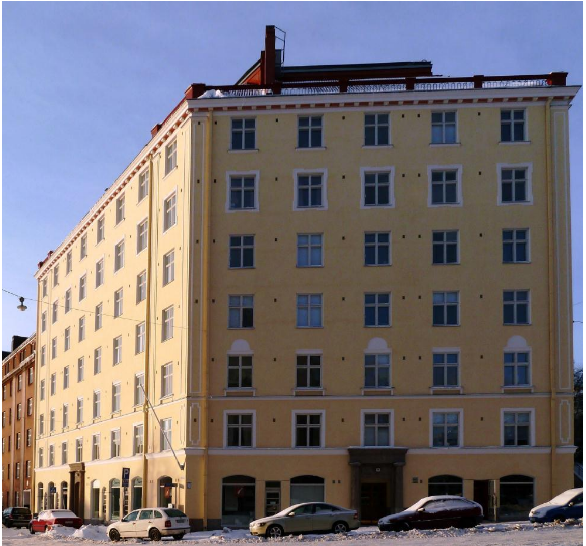
Kuva 8. As Oy Mäkilinnan julkisivut Agricolankadun ja Torkkelinkadun kulmasta.
