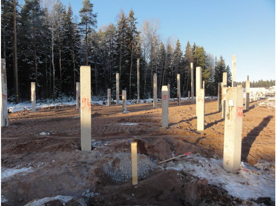
Kuva 1. Teräsbetonipaaluja asennettuna.
