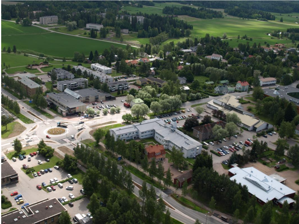
Kuva 5. Viistoilmakuva Nikkilän Kuntalasta vuonna 2010 luoteesta kuvattuna. Kuva © Sipoon kunta.
