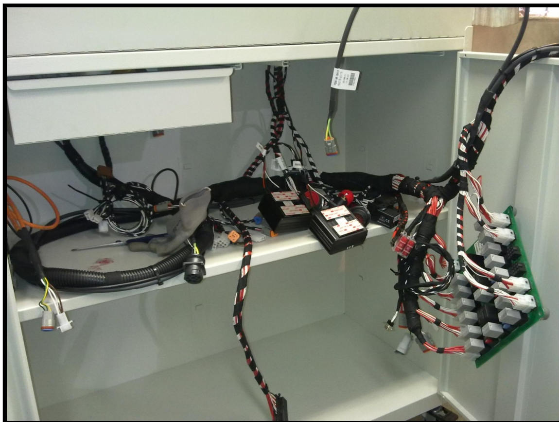
Kuva 9. Ohjaamon pääjohtosarjan asennus. (Kuva: Jani Varis.)
