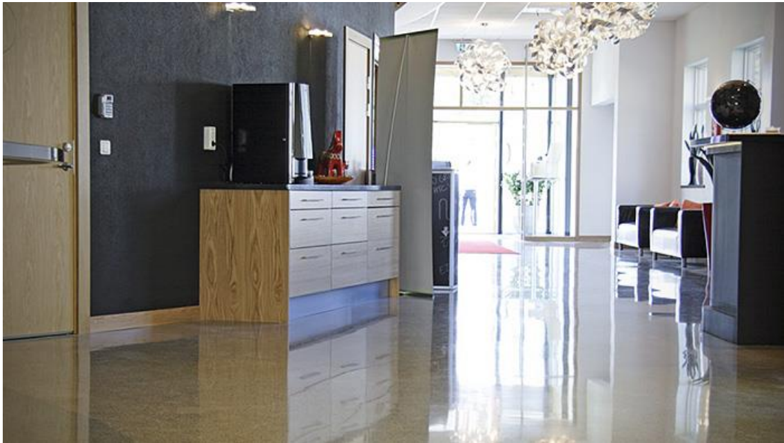
KUVA 15. Kiiltäväksi hiottua betonipintaa (17.)
