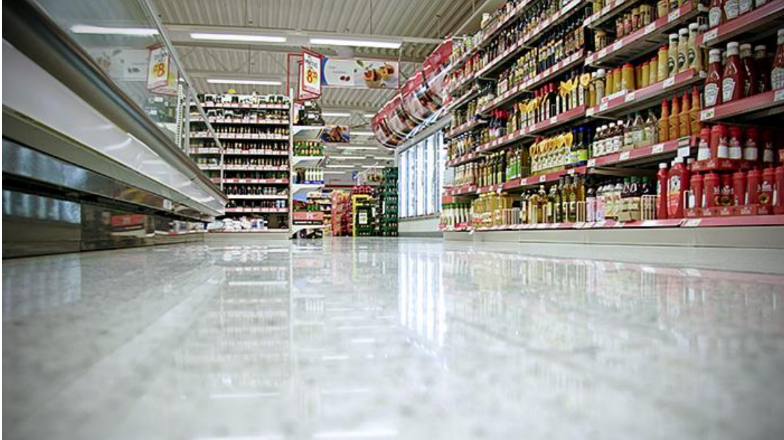
KUVA 20. Valmista mosaiikkibetonilaatta pintaa (22)
