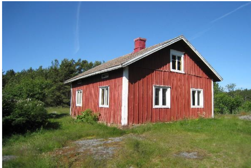
Kuva 4. Asuinkerroksen vaihdetut keskijakoiset ikkunat etelä- ja itäseinällä.
