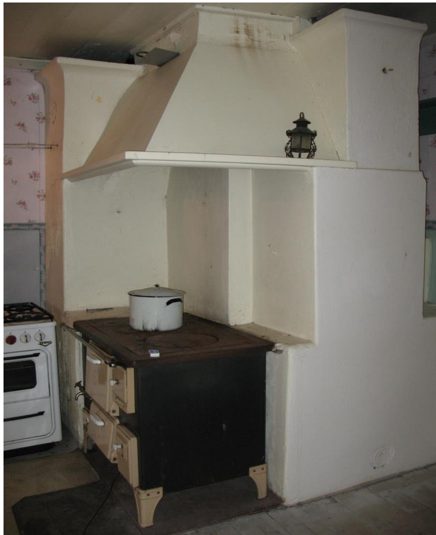
Kuva 12. Tuvan vanha leivinuunimuuri ja Högforsin valurautaliesi.
