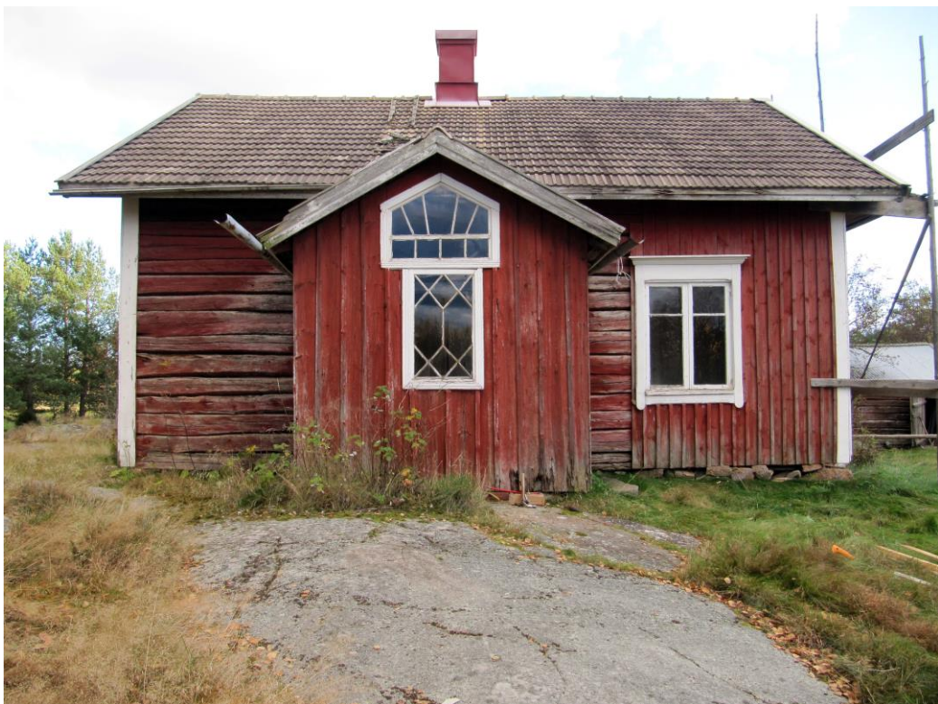
Kuva 5. Pohjoisseinän lautarakenteinen kuisti ja kertaustyylliset ikkunat.
