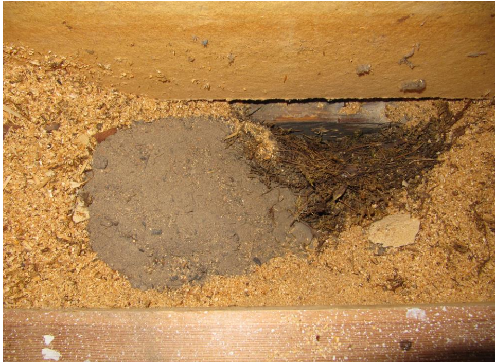
Kuva 23. Täytepohjalattian eristeinä hiekkaa, purua ja sammalta seinää vasten.
