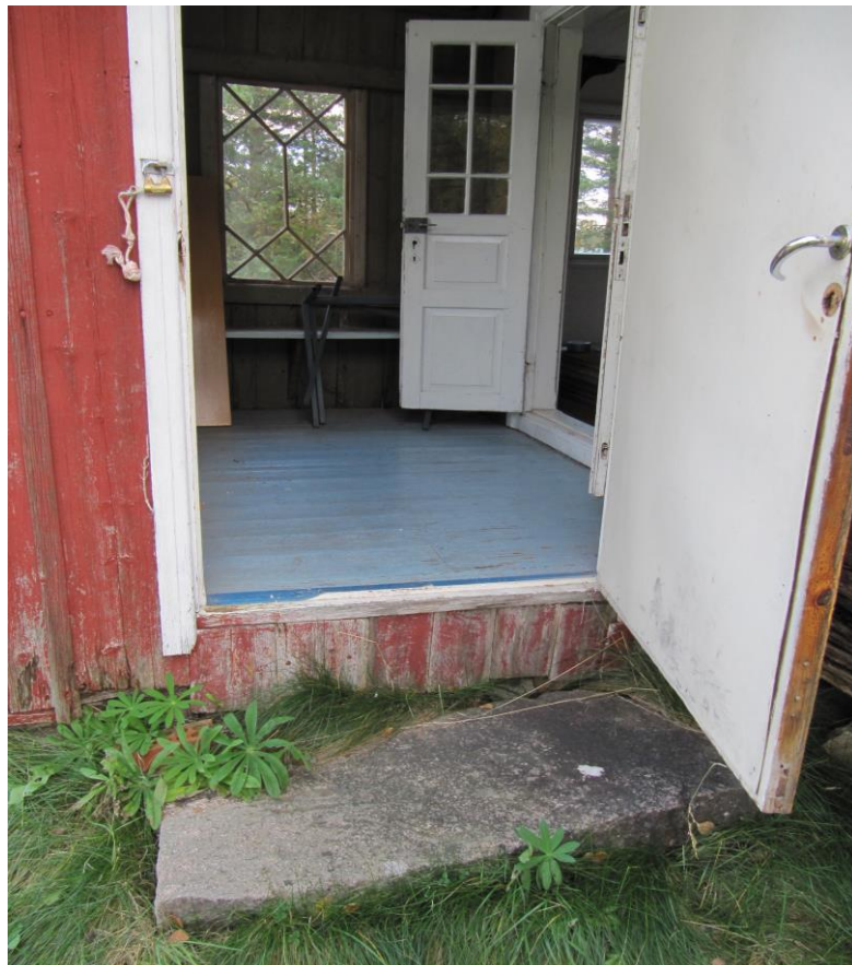
Kuva 7. Alkuperäiseltä paikaltaan siirretty kuistin sisäänkäynti.
