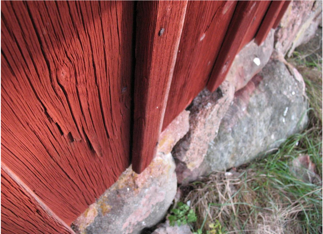
Kuva 9. Kohderakennus maalataan punamullalla korjaustöiden jälkeen.
