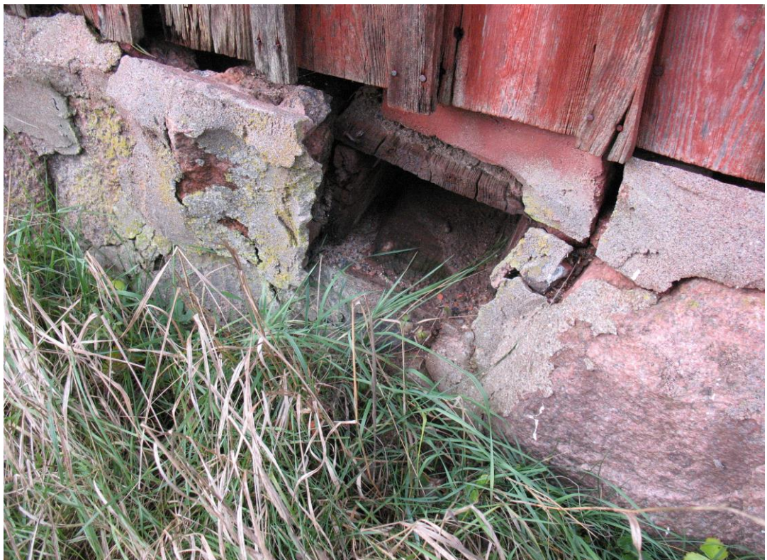
Kuva 10. Tuvan multapenkkirakenteen tuuletuskanava.
