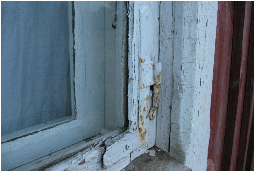
Kuva 14. Alkuperäisen ikkunan kulmasarana on 1800-luvun jälkipuolelta.
