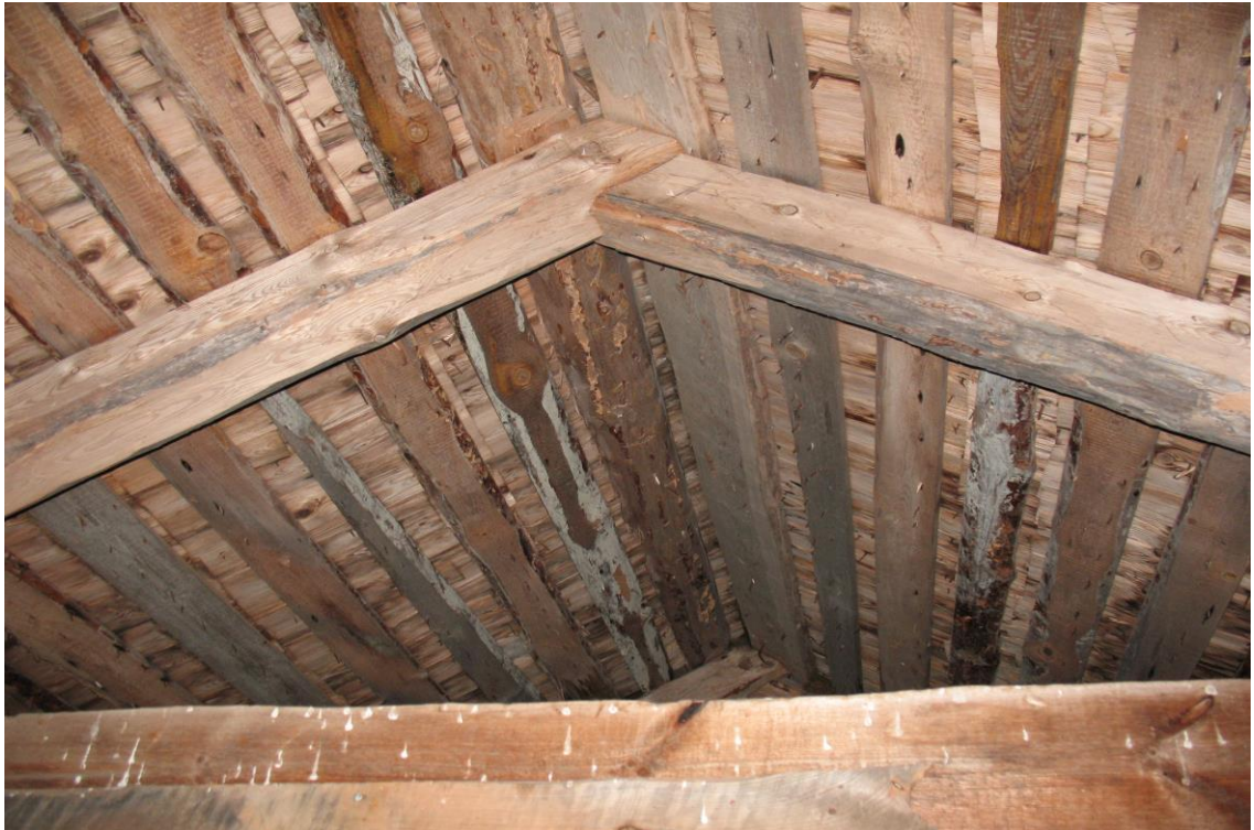
Kuva 11. Pärekatto on jäänyt aluskatteeksi betonitiilen aikakaudella.
