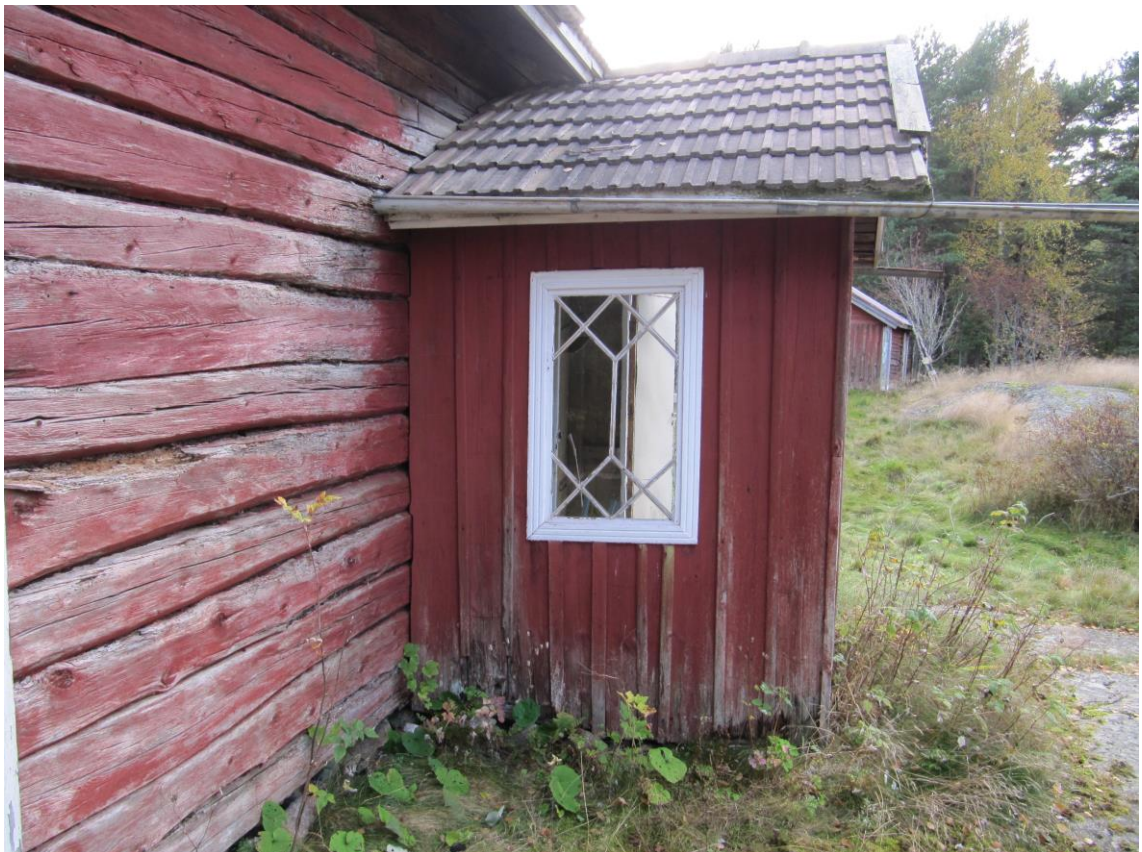
Kuva 15. Veden virheellinen ohjautuminen on koetellut seinähirsiä.
