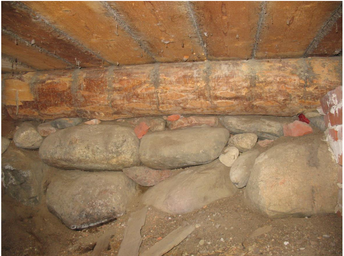
Kuva 21. Multapenkkiä rajaa jyrävä kivimuuri. Yläpuolella tuvan lattialankut.
