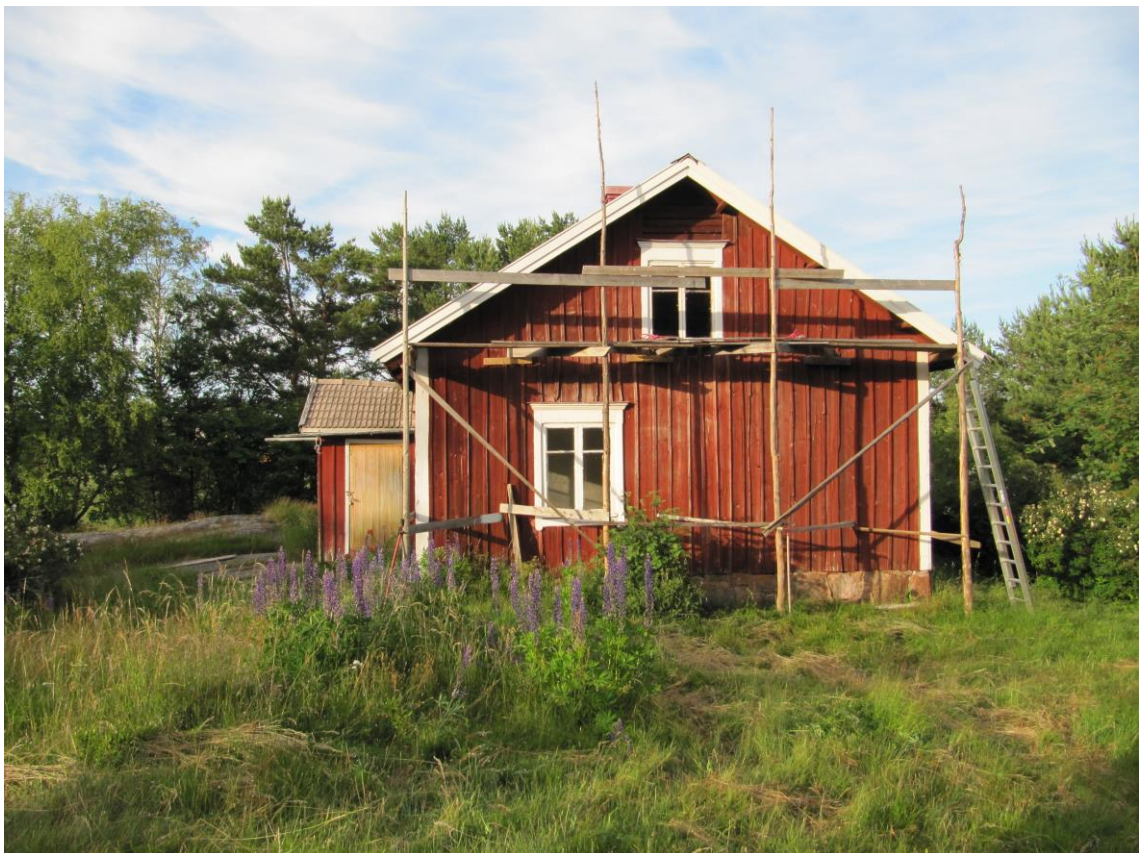
Kuva 2. Länsipääty alkuperäisine ikkunoineen. Kuva: Mikael Lindholm.
