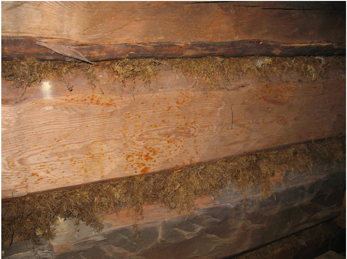
Kuva 28. Hirsiseinän sammaleristettä vintillä rakennuksen päätykolmiossa.
