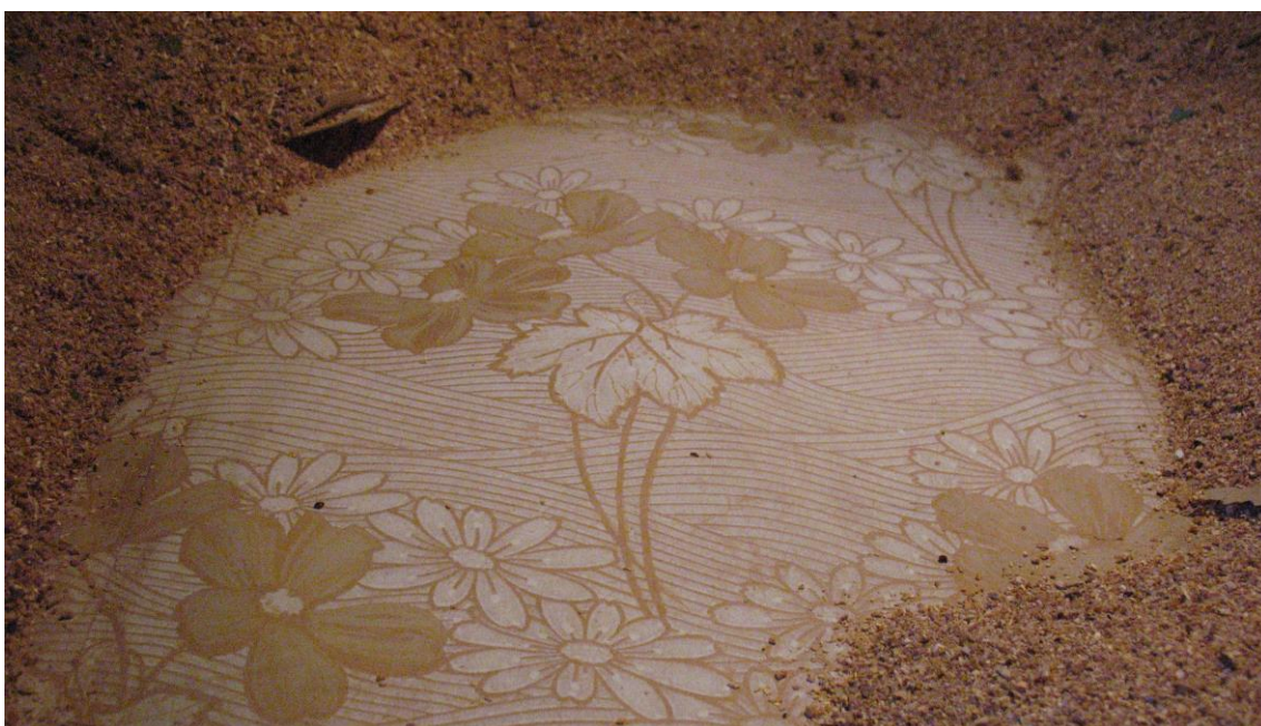
Kuva 18. Yläpohjan kuivaa purueristettä ja sen kukkakuvioitua aluspahvia.
