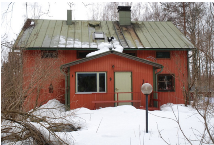
Kuva 4. Tyypillinen 1½kerroksinen puutalo.
