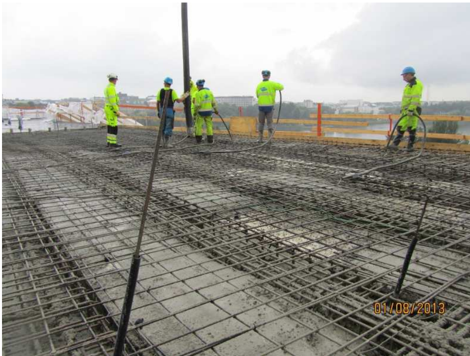
Kuva 20. Laatan betonointityöt käynnissä [2]
