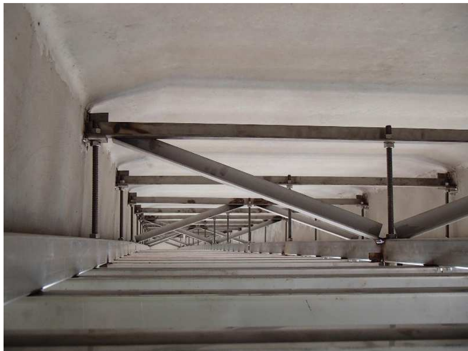
Kuva 12. Kannakkeisiin kiinnitetty teräsrunko. [2]
