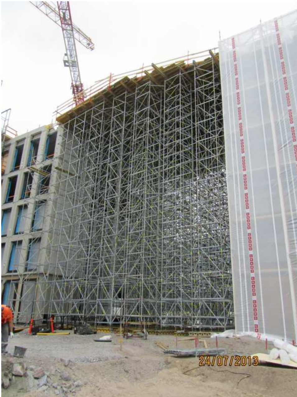
Kuva 17. Tukitornit ja muotti [2]
