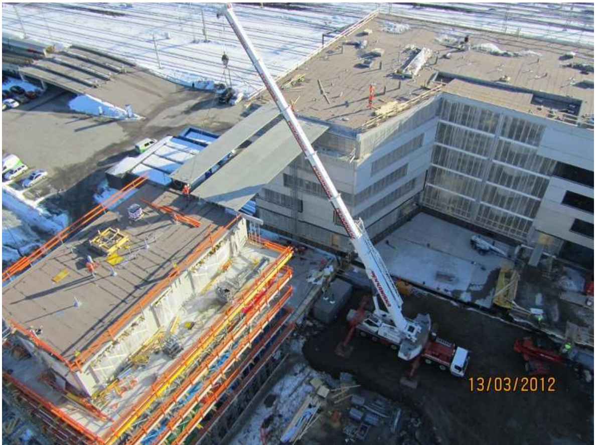
Kuva 9. TT-laattojen asennus käynnissä T2-lohkolla. [2]
