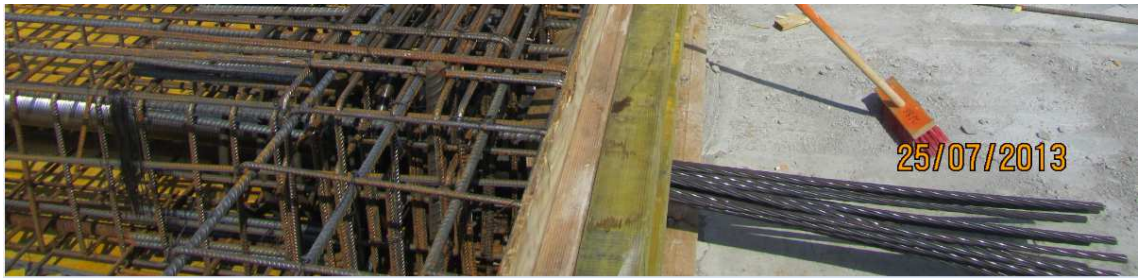
Kuva 21. Suojaputki ja jänteet [2]
