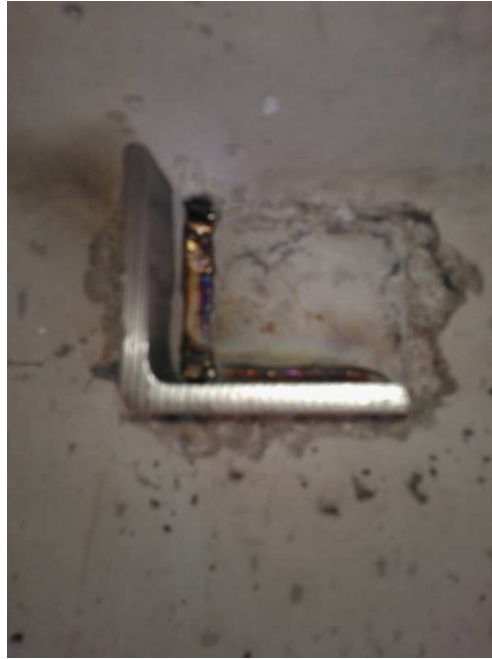
Kuva 11. TT- laatan ripan kylkeen hitsattu teräsrungon kannake. [2]
