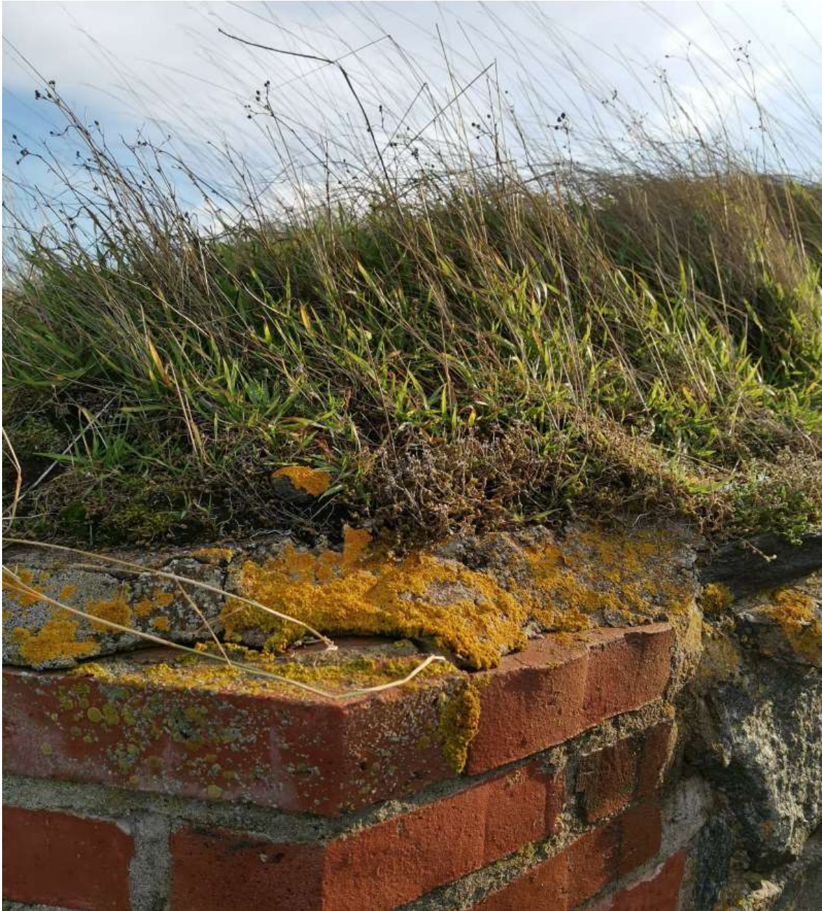
Kuva 7. Linnoituslaitteiden päällä olevaa maamassaa ja siinä kasvavaa heinäkasvillisuutta.
