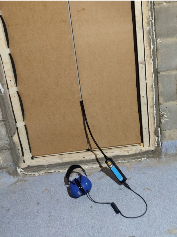
Kuva 10. Ultraäänimittari ja mitattava levyrakenteen.
