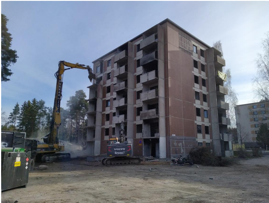
Kuva 6. Betonirungon purku käynnissä.
