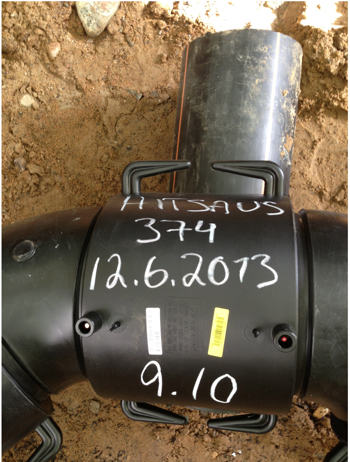
Kuva 11. Valokuva sekä paikkatieto hitsausliitoksesta helpottaa mm. valvontaa.
