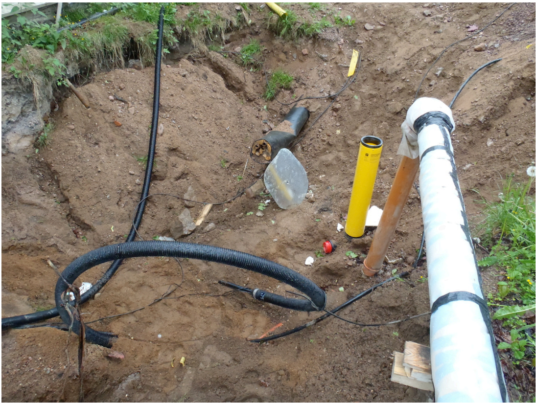
Kuva 4. Uusi ja vanha viemäri.
