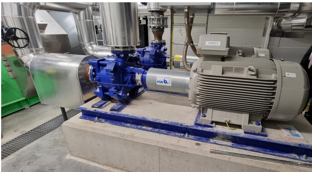
Kuva 17, Kaukolämpöpumput (Vuorio, 7.12.2021)
