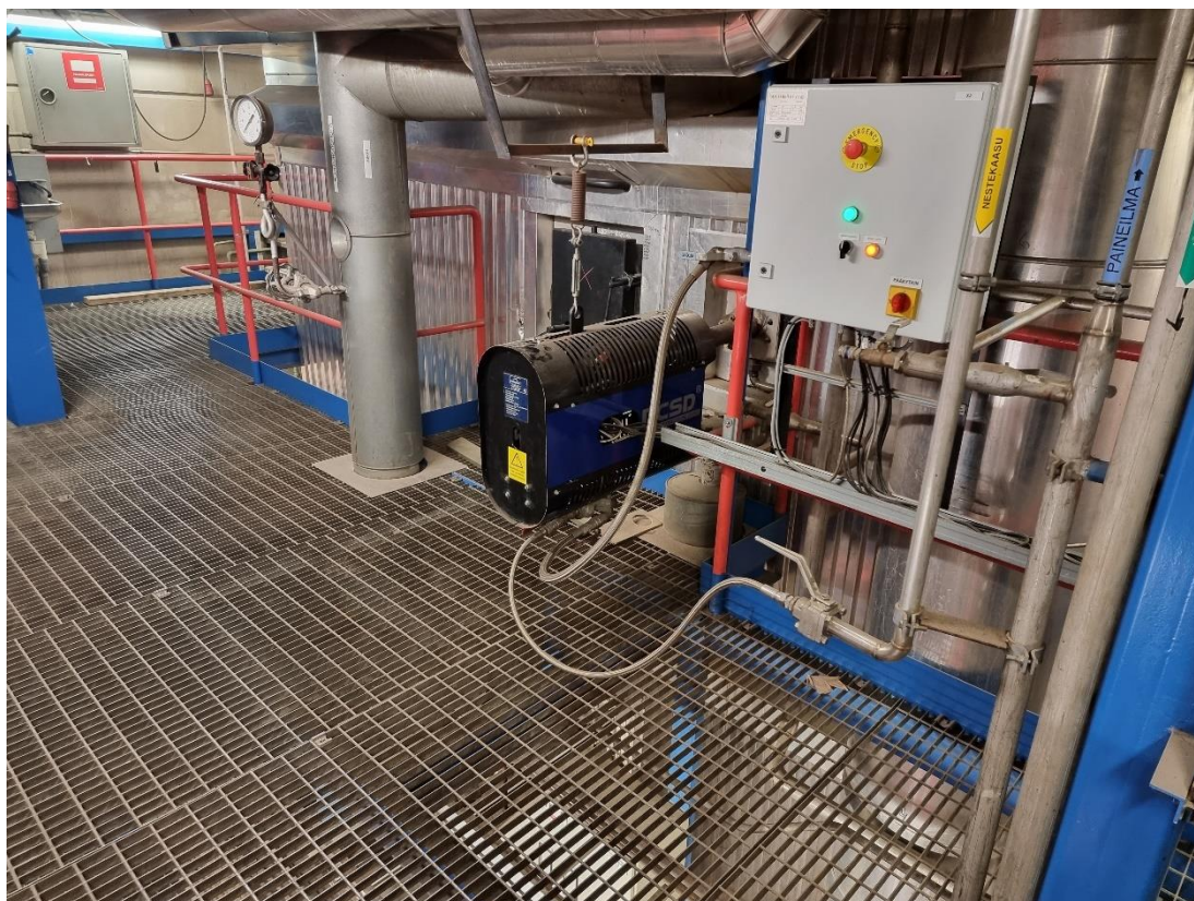
Kuva 9, Nestekaasulla ja paineilmalla toimiva ääninuohoin (Vuorio, 7.12.2021)
