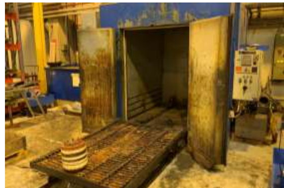
Käämintäpuolen kuivausuuni, vanha ohjauskeskus uunin sivussa oikealla
