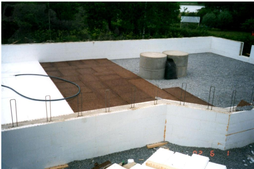
Kuva 12. Rakenteilla oleva lämpöalapohja (M. Alander Oy 2013).
