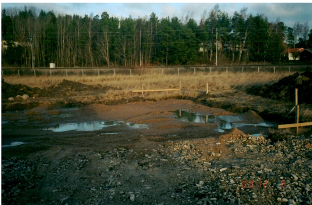
Kuva 8. Salaojitukset ja kapillaarikatko saattavat tulla tarpeeseen (M. Alander Oy 2013).
