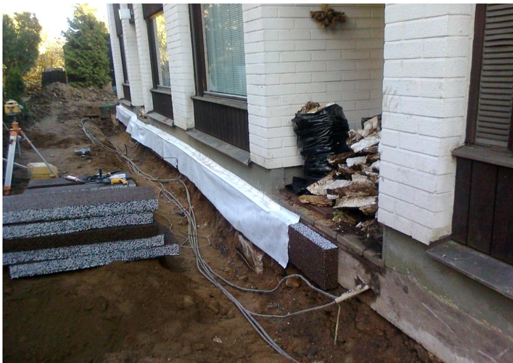
Kuva 9. Matalaperustaisen rivitalon sokkelieristys (M. Alander Oy 2013).
