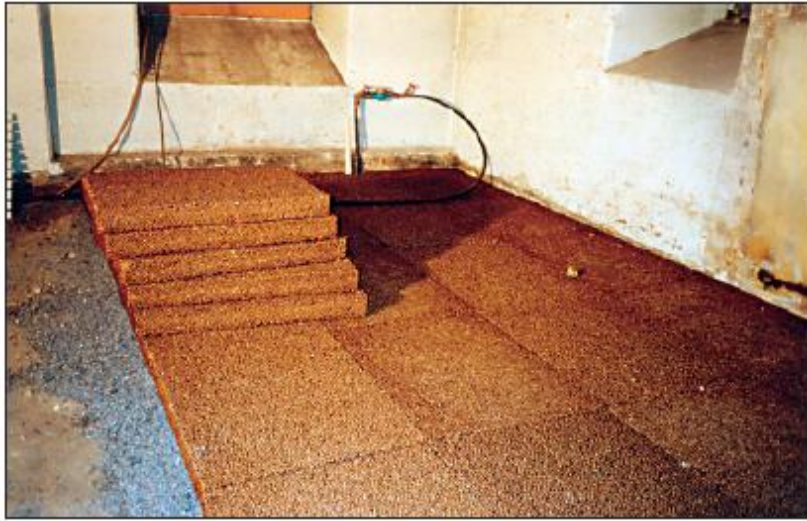
Kuva 14. Turun piispantalon lattia korjaustöiden alla (Fuktisol RT 38151).
