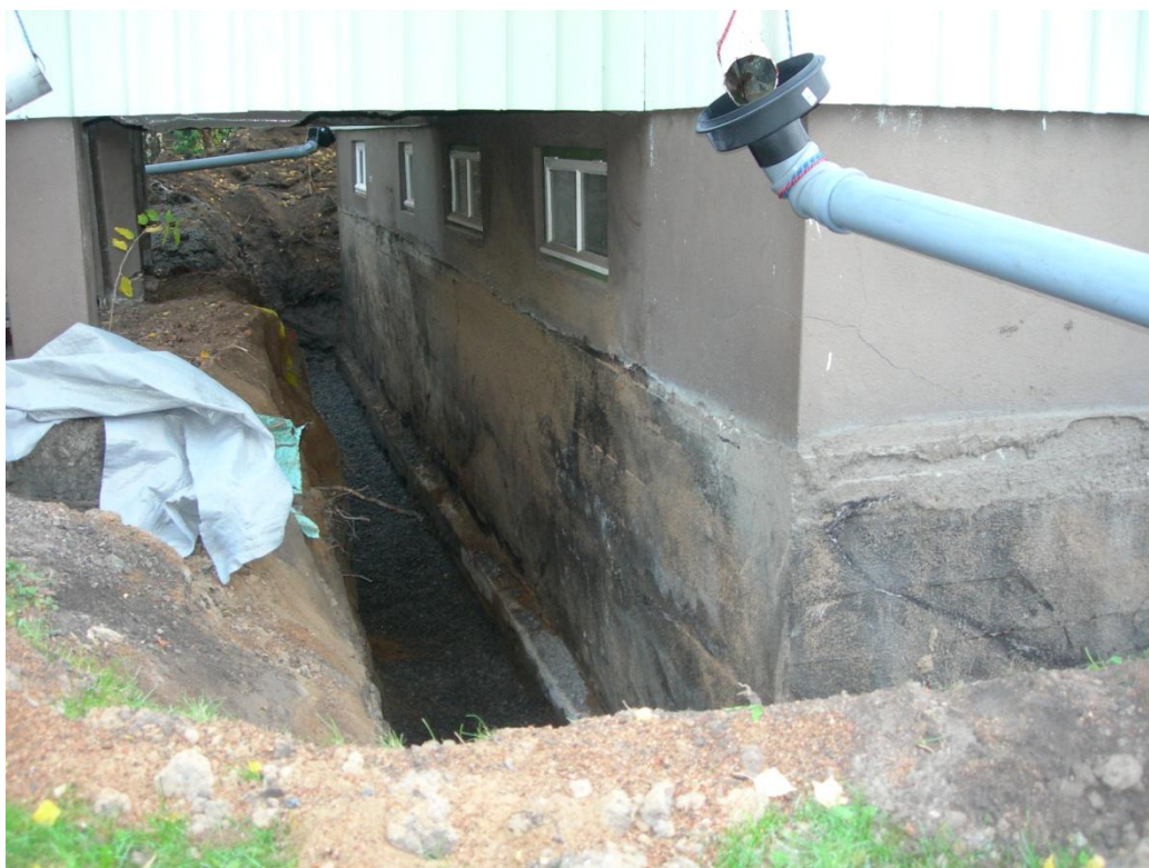
Kuva 6. Sokkeli, josta vesieristys on poistettu painepesulla ja kaivannon pohja sepelöity (M. Alander Oy 2013).
