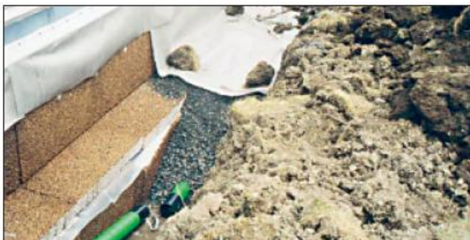
Kuva 7. Anturallisen perustuksen saneerauksen vaiheet (Fuktisol RT 38151).
