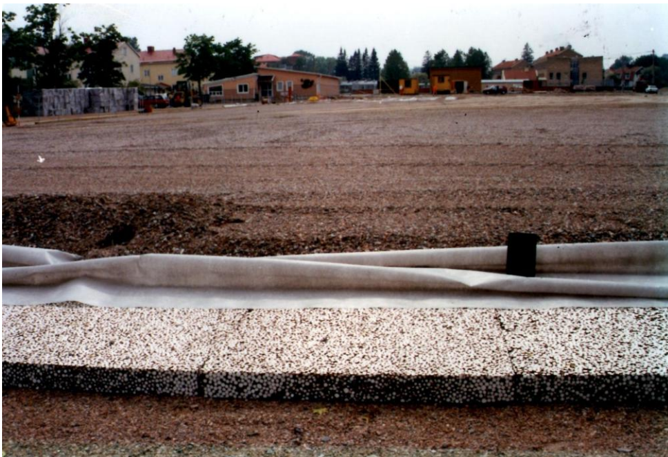
Kuva 18. Kauttaaltaan Fuktisolilla eristetty urheilukenttä (M. Alander Oy 2013).
