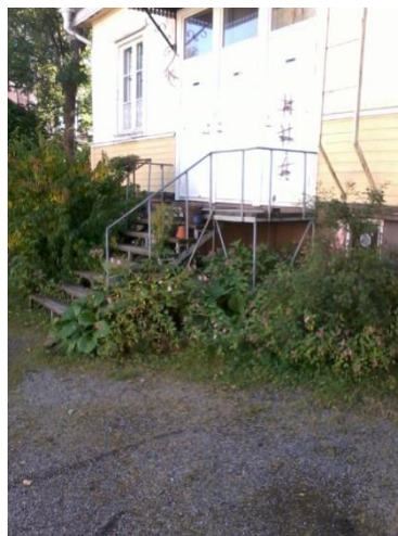
Kuva 9. Sokkelin väliaikainen tuenta.
