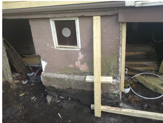
Kuva 9. Sokkelin väliaikainen tuenta.
