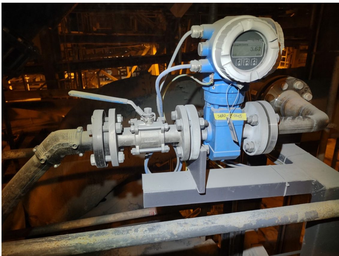
KUVA 16. Vaihdettu virtausmittari
