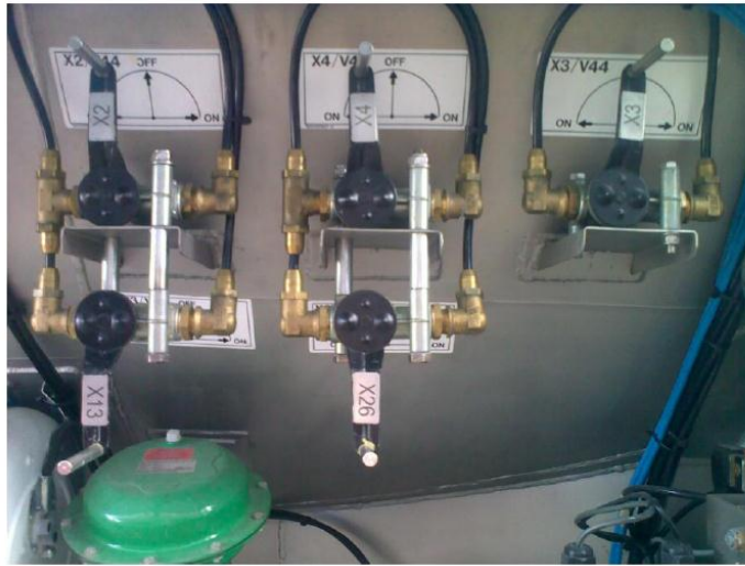
KUVA 11. Sulkuventtiilien ohjaisventtiilit (Gasum Oy).
