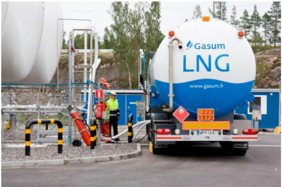
KUVA 3. Maakaasun lastaus Kilpilahti (Gasum Oy).
