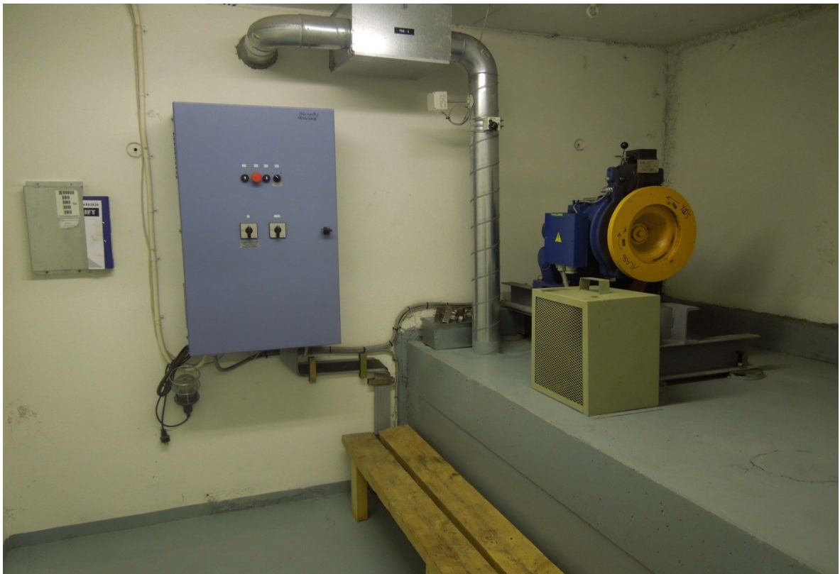
Kuva 10. Edellisen kuvan konehuone siivouksen jälkeen.
