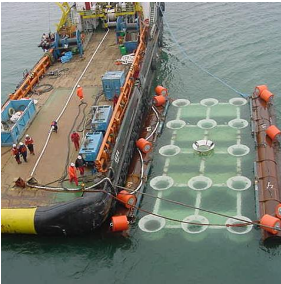
Kuva 12. Porauskehikon uittaminen paikalleen asentamista varten (Claxton, 2013)
