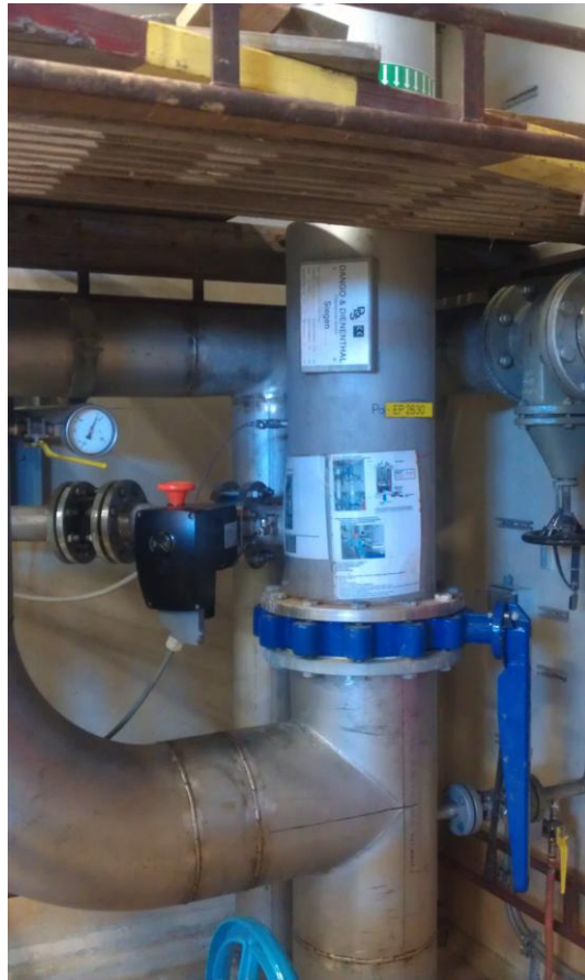
Kuvio 15. Automaattinen vastavirtahuuhdeltava suodatin.
