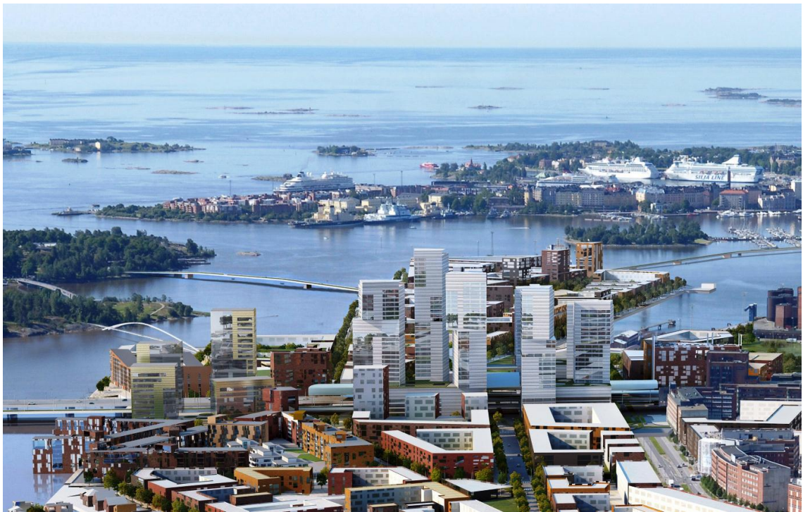
Kuva 1. Kalasadaman keskuksen havainnekuva pohjoisesta otettuna. Kuvan vasemmassa reunassa näkyy Kulosaaren silta ja taustalla on Katajanokka. [Helin & Co. Arkkitehdit]
