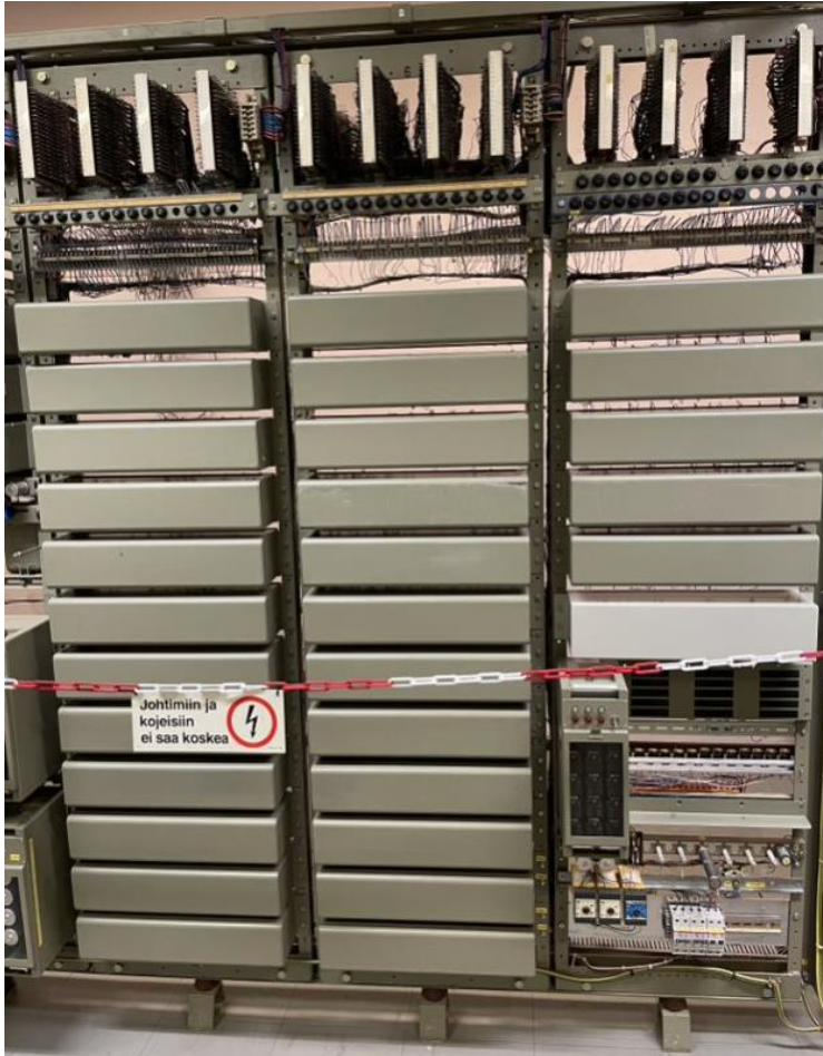
Kuva 6. Varkauden releasetinlaitteelta käytössä olevia reletelineitä 3kpl
