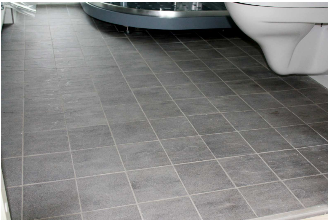
Kuva 12 Lattia on laatoitettu elävöpintaisella laaatalla. [14]
