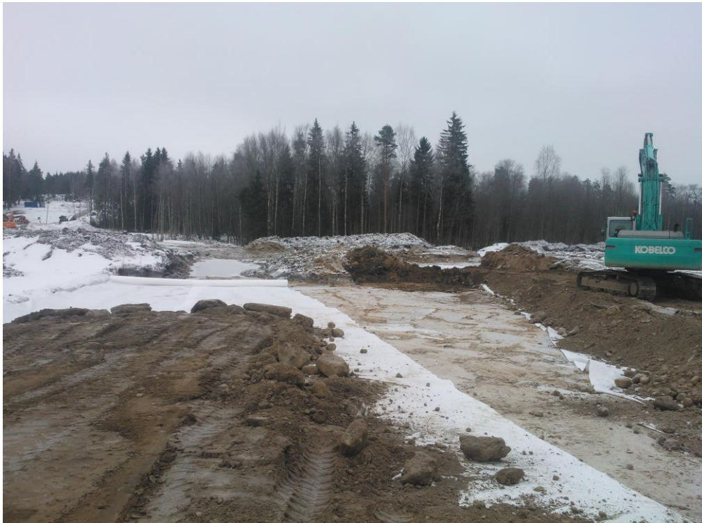
Kuva 16. Esikuormituspenkereen rakentaminen
