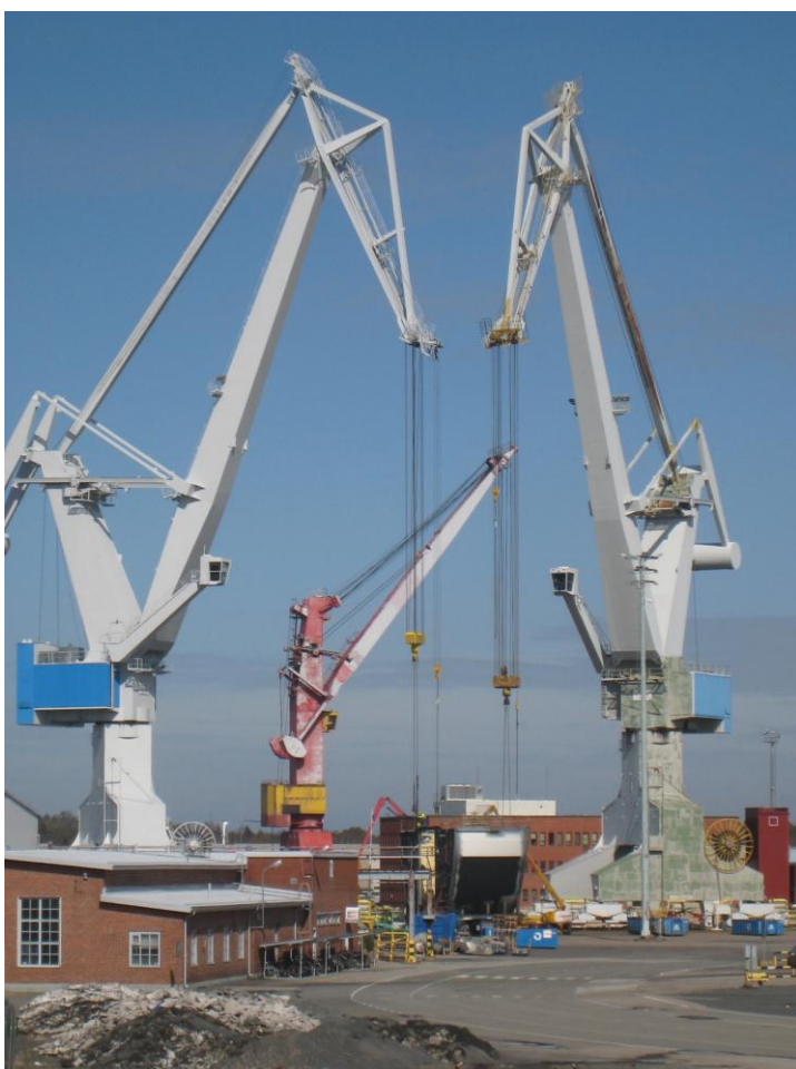
Kuva 6. rakennusaltaan 150-tonnin nosturit (Sami Santalahti 18.4.2013)
