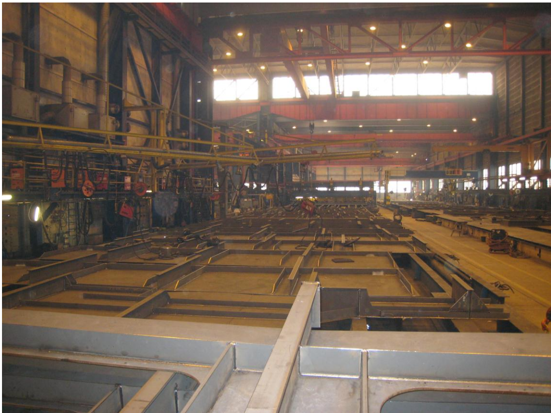
Kuva 11. Lohkotehtaan kansirakenne-linja (Sami Santalahti 18.4.2013)
