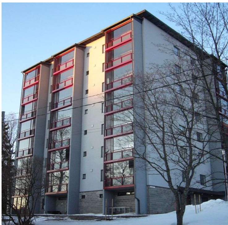
KUVA 1. Tutkittava kohde remontin jälkeen. Lisäeristyksen ja levyrappauksen myötä rakennuksen ulkonäkö muuttui. Kuva Tommo Hämäläinen. 2013
