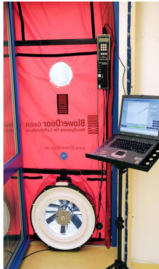
Tiiveysmittauslaitteisto ulko-ovi aukossa
