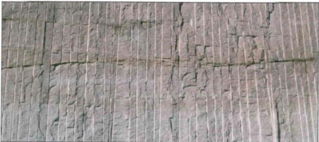
KUVA 4. Tarkkuuslouhittu kallioseinä (2, s. 261)
