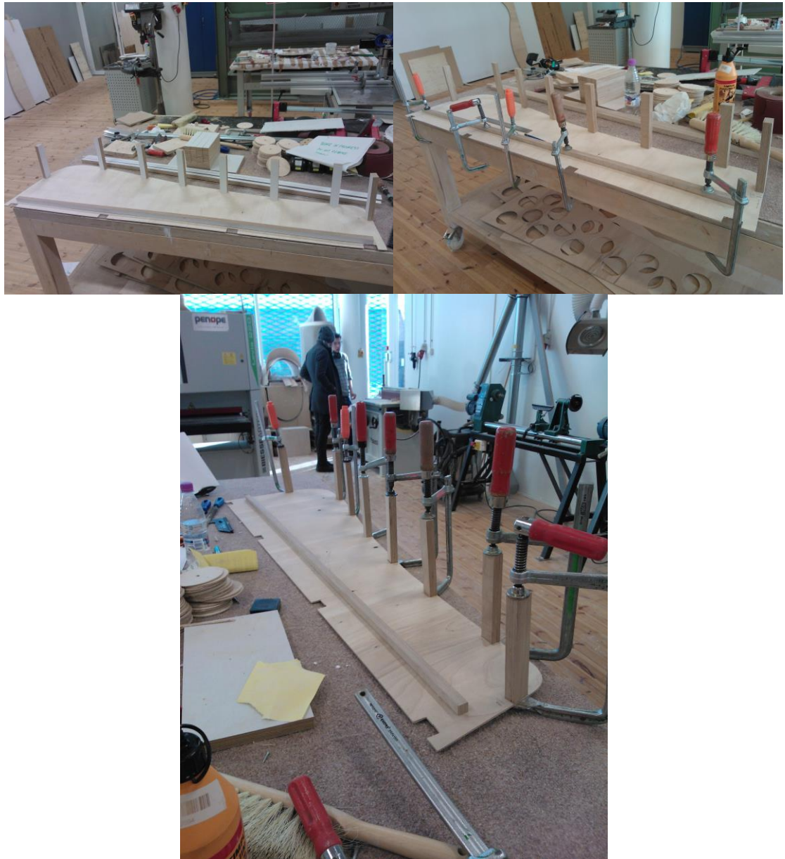
Kuva 26. Jäykistävän rangon sekä pystytukien liimaus pohjalevyihin.
