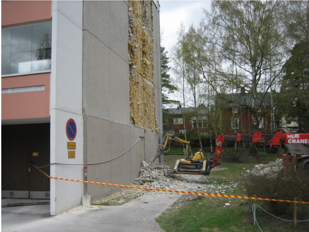
Kuva 13. Ulkokuoren purkua piikkausrobotilla. [15]
