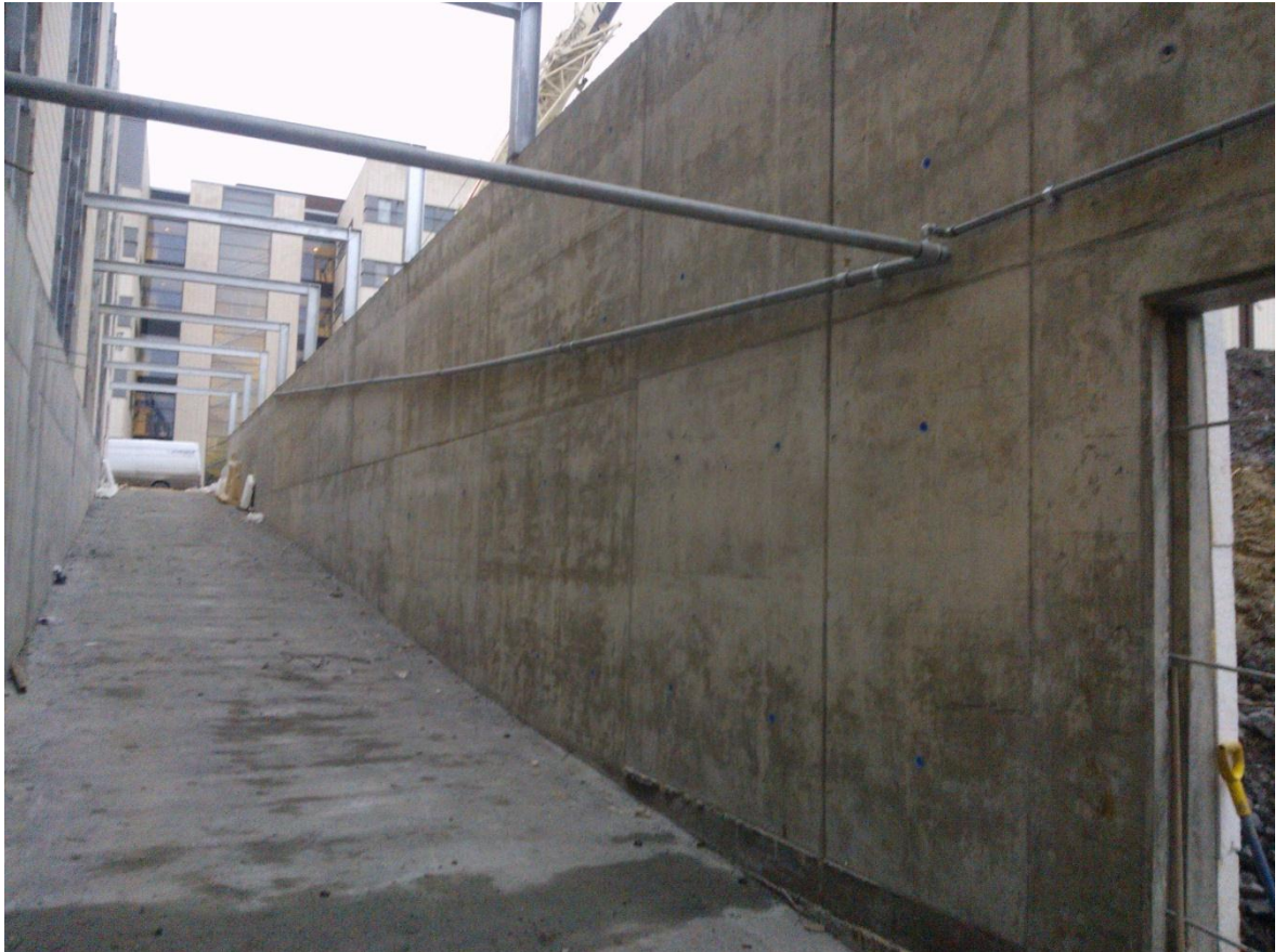
Kuva 5. Ajoluiskan sprinklaus ennen tarkastusta.
