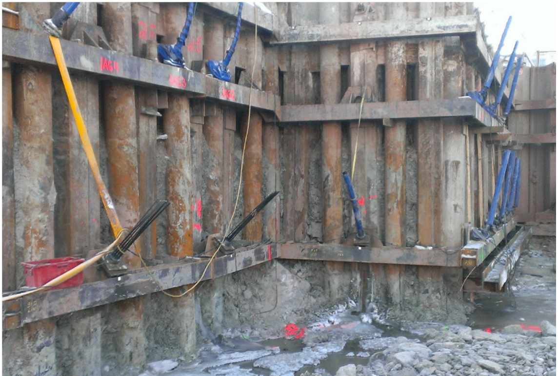
Kuva 9. Kuvassa tukiseinäosuutta, joka on vahvistettu porapaaluilla
