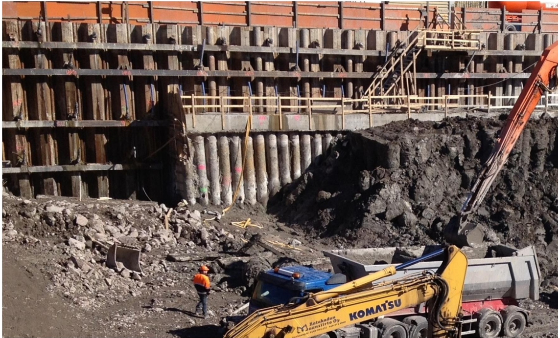
Kuva 21. Ponttiseinän eteen tehtyä porapaaluseinää.(13)
