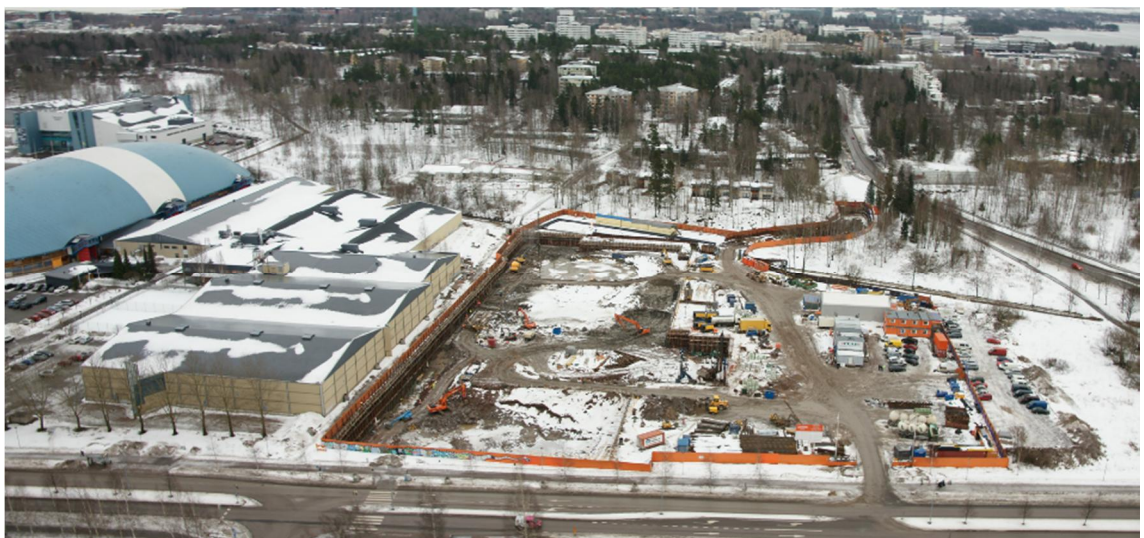
Kuva 2. Ilmakuva työmaasta, vasemmalla mm. Barona- ja Esport-areenat (3).
