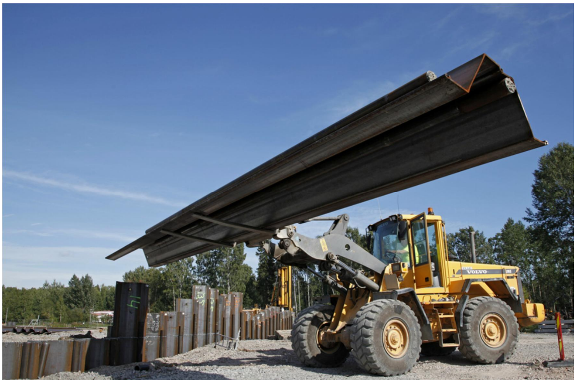
Kuva 11. Teräsponttiprofiili, johon on hitsattuna työputket.(3)
