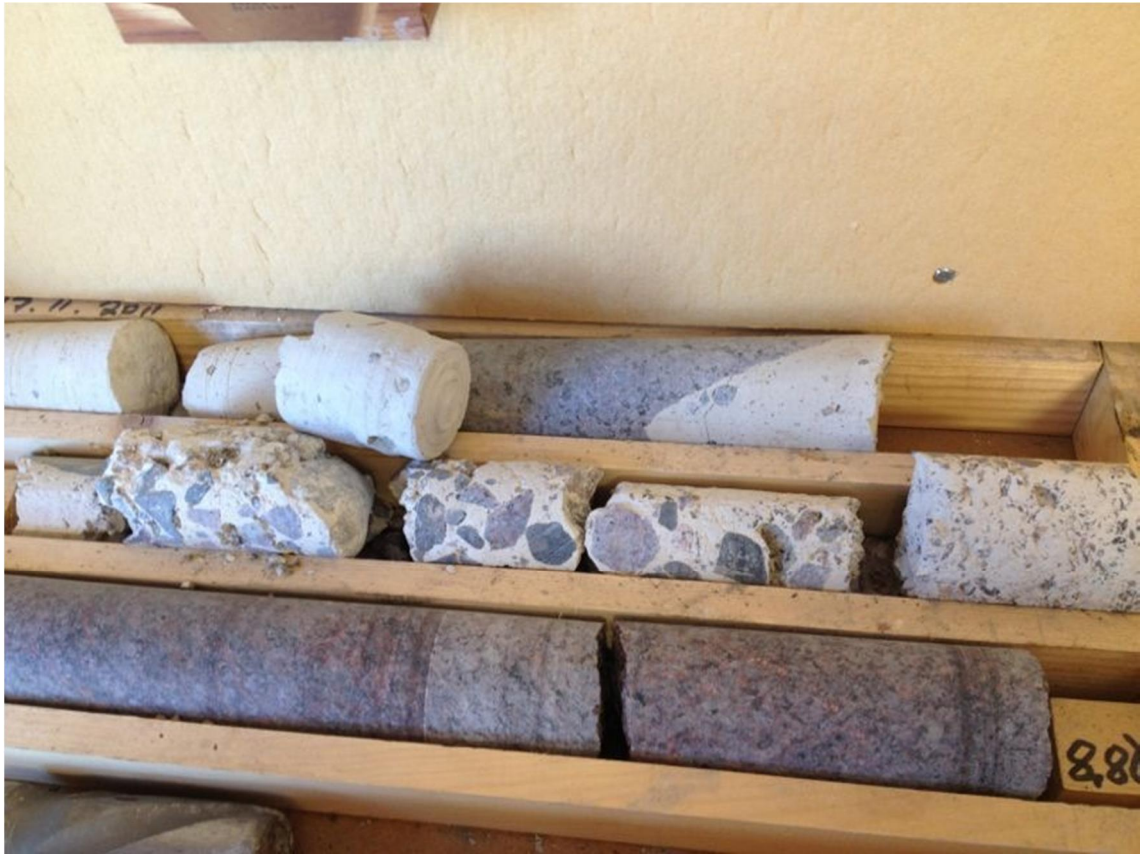
Kuva 12. Porattuja näytteitä valmiista suihkupaalutuksesta sekä kalliosta.(13)
