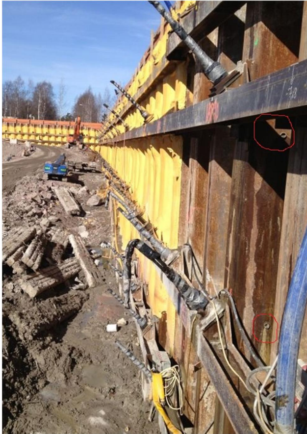
Kuva 16. Ympyröitynä on pari kappaletta injektointinippoja.(13)
