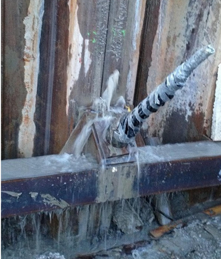
Kuva 15. Vuotava ankkurikotelo (13)
