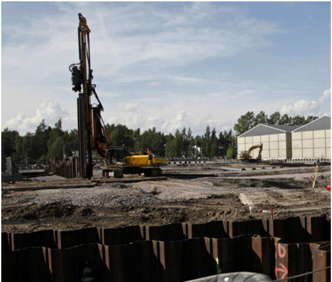
Kuva 5. Ponttiseinän asentamista Urheilupuiston työmaalla (3)
