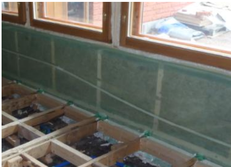
Kuva 35. Höyrynsulku seinän sisäpinnassa.
