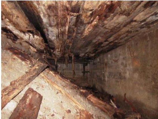
Kuva 20. Tuulettuvassa alapohjassa muottilaudoitukset on jätetty paikoilleen. [20.]
