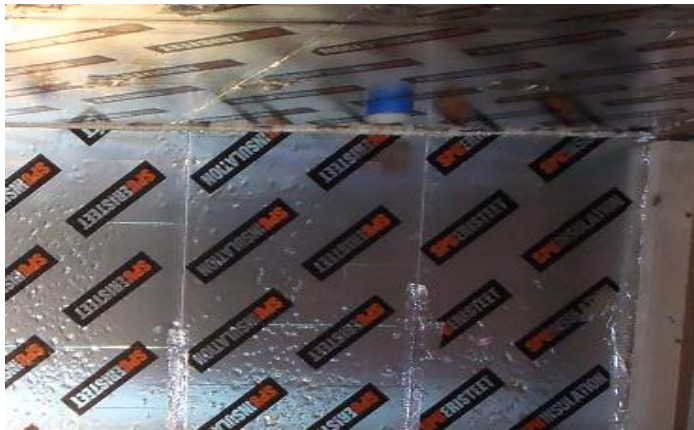
Kuva 36. Lisälämmöneristys XPS-eristeellä.
