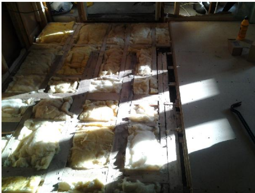
Kuva 12. Betonilaatan päällä puukoolaus ja mineraalivilla.
