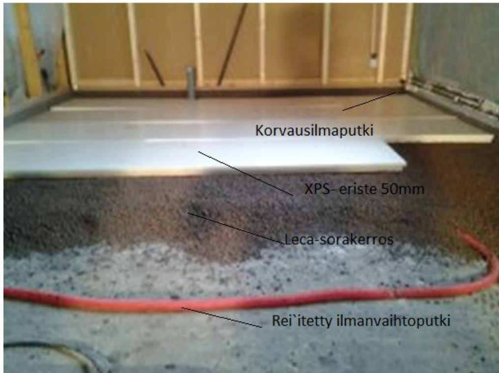
Kuva 16. Ilmastoidun lattian rakenne.
