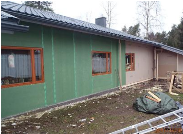
Kuva 47. Rakennukseen on asennettu uudet tuulensuojalevyt.
