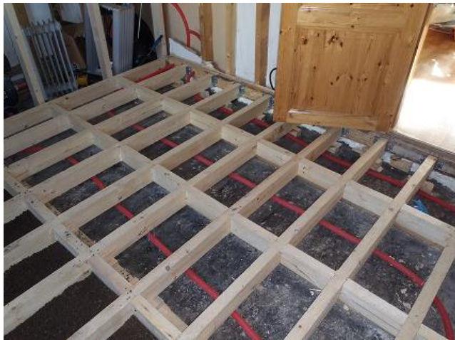
Kuva 50. Maanvaraisen betonilaatan päällä puukorotettu lattia.
