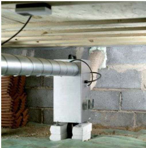
Kuva 23. Ilmankuivain tuulettuvassa alapohjassa. [23.]
