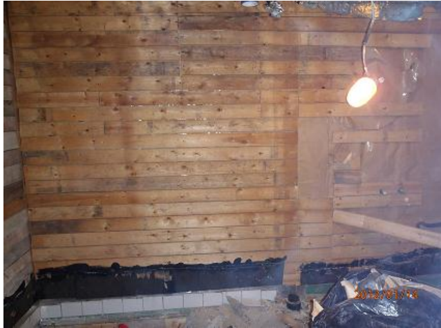
Kuva 49. Saunan ja pesuhuoneen purku.
