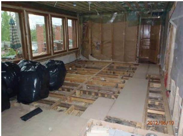
Kuva 54. Olohuoneen lattia purettuna.
