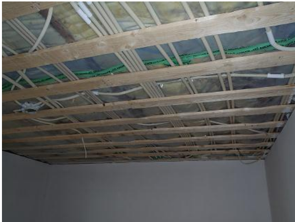
Kuva 52. Yläpohjan höyrynsulku.
