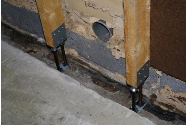
Kuva 33. Rungon alaohjauspuu on poistettu ja korvattu valesokkelikengillä. [25.]
