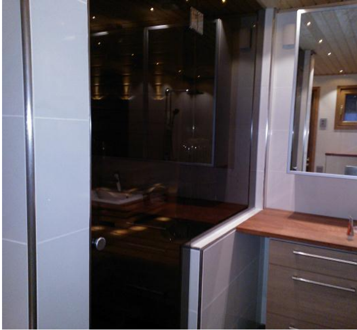
Kuva 59. Saunan ja pesuhuoneen välinen lasiseinä
