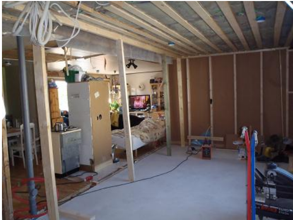
Kuva 53. Keittiö ja olohuoneen välinen seinä on purettu.
