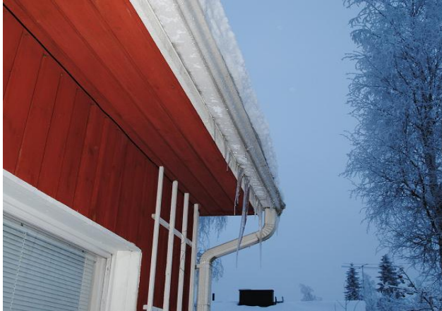
Kuva 38. Yläpohjan lämpövuoto.
