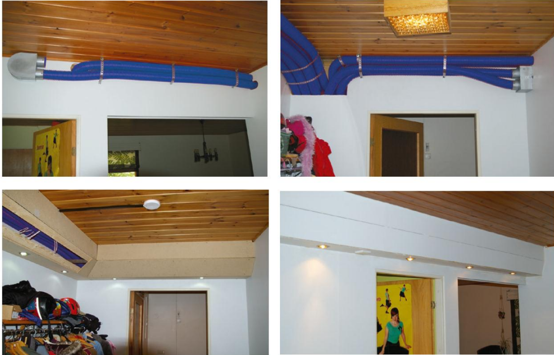
KUVA 10. Vallox Blue Sky -kanavan asennus saneerauskohteeseen (11)
