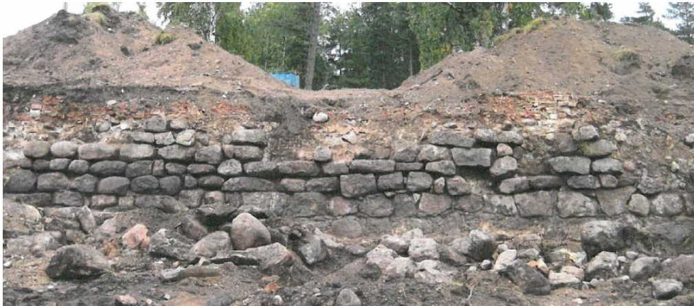
Kuva 22 Kesällä 2012 patterin korjaustyöt käynnissä (Museovirasto 2013).
