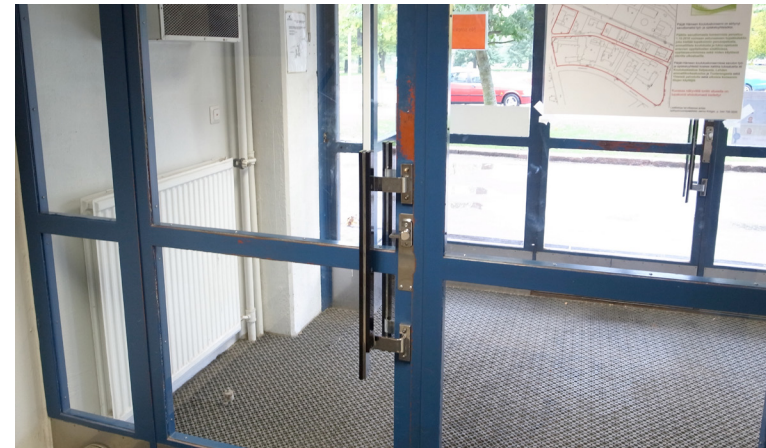
3. Lahden ammattikorkeakoulun ovi jonka pintamaali on kulunut pois
