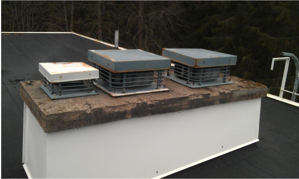
KUVA 13. Poistopuhaltimia katolla (21.11.2012)
