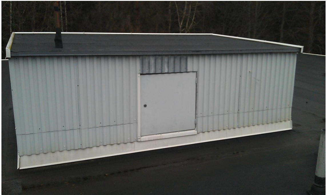
KUVA 17. Nykyinen ilmanvaihtokonehuone katolla (21.11.2012)
