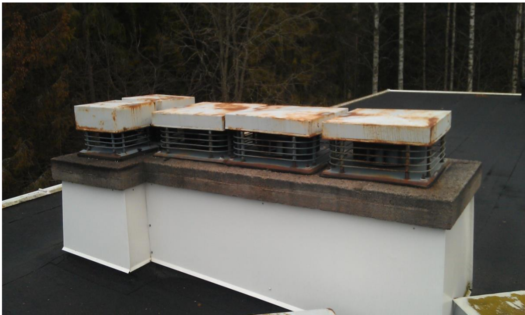
KUVA 14. Poistopuhaltimia katolla (21.11.2012)
