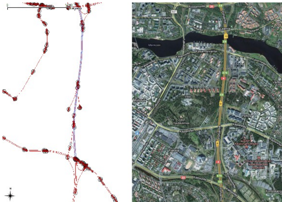
KUVA 6: Oulun läpi kulkeva moottoritie (Pohjantie, tie 4), Kainuuntien (22) ja Poikkimaantien (8155) välissä oleva tieosa (410) kokonaisuudessaan molemmilla ajoradoilla. Vasemmanpuoleisessa kuvassa Digiroad-aineistosta QGIS-ohjelmalla renderoituna, oikeanpuoleisessa kuvassa Google Maps -palvelusta.
