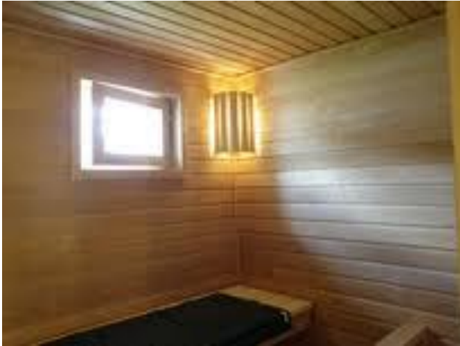
KUVA 4. Perinteisin saunan valaisin löytyy seinältä tai lauteiden alle sijoitettuna (tavallisimmin valonlähteenä halogeenilamppu eli hehkulamppu) (26)
