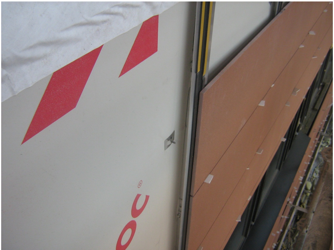
Kuva 3.1 Julkisivulaatoitus kannakoitu eristekerroksen läpi runkorakenteeseen
