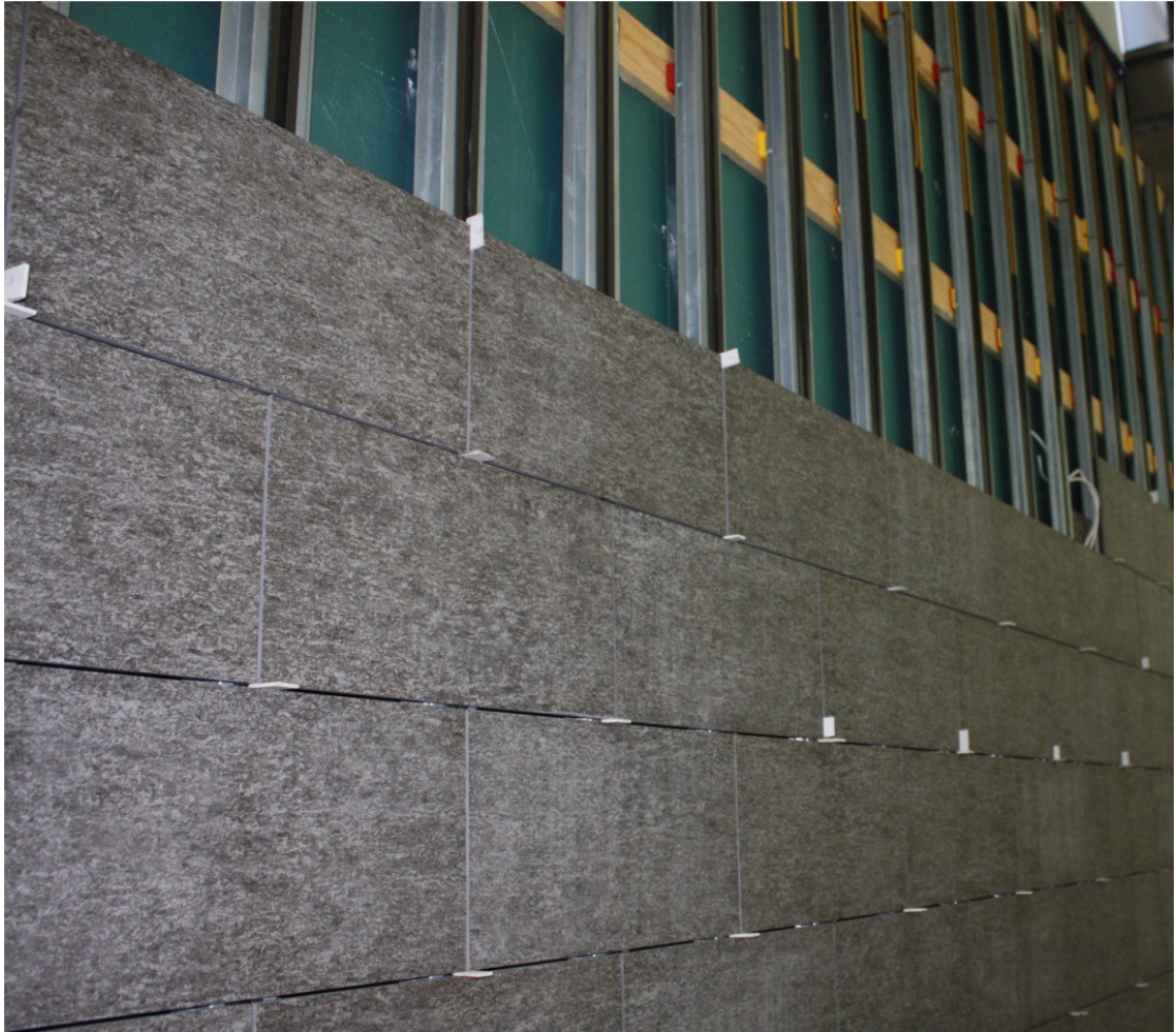
Kuva 3.3 Laatoituksen kiinnittäminen hattuorsilla puurunkoiseen seinään
