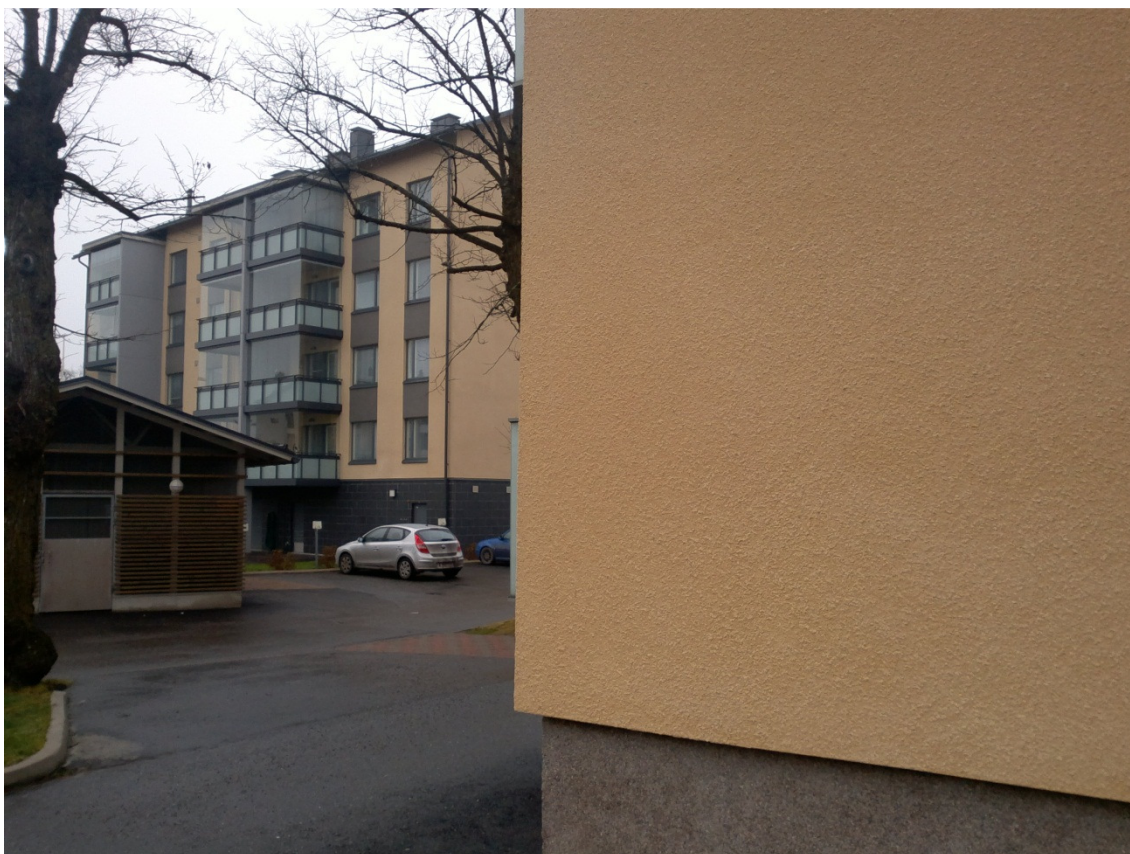
Kuva 6.7 Ohutrappausmenetelmällä lämpöräpättyjä julkisivuja
