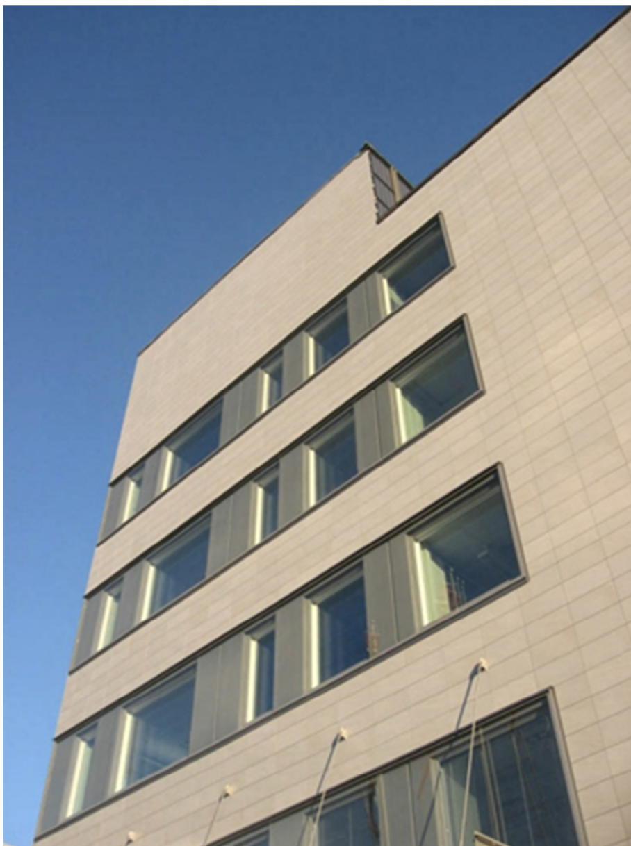
Kuva 3.5 StoneMate-järjestelmällä toteutettu kauppakeskus Gallerian julkisivu Lappeenrannassa
