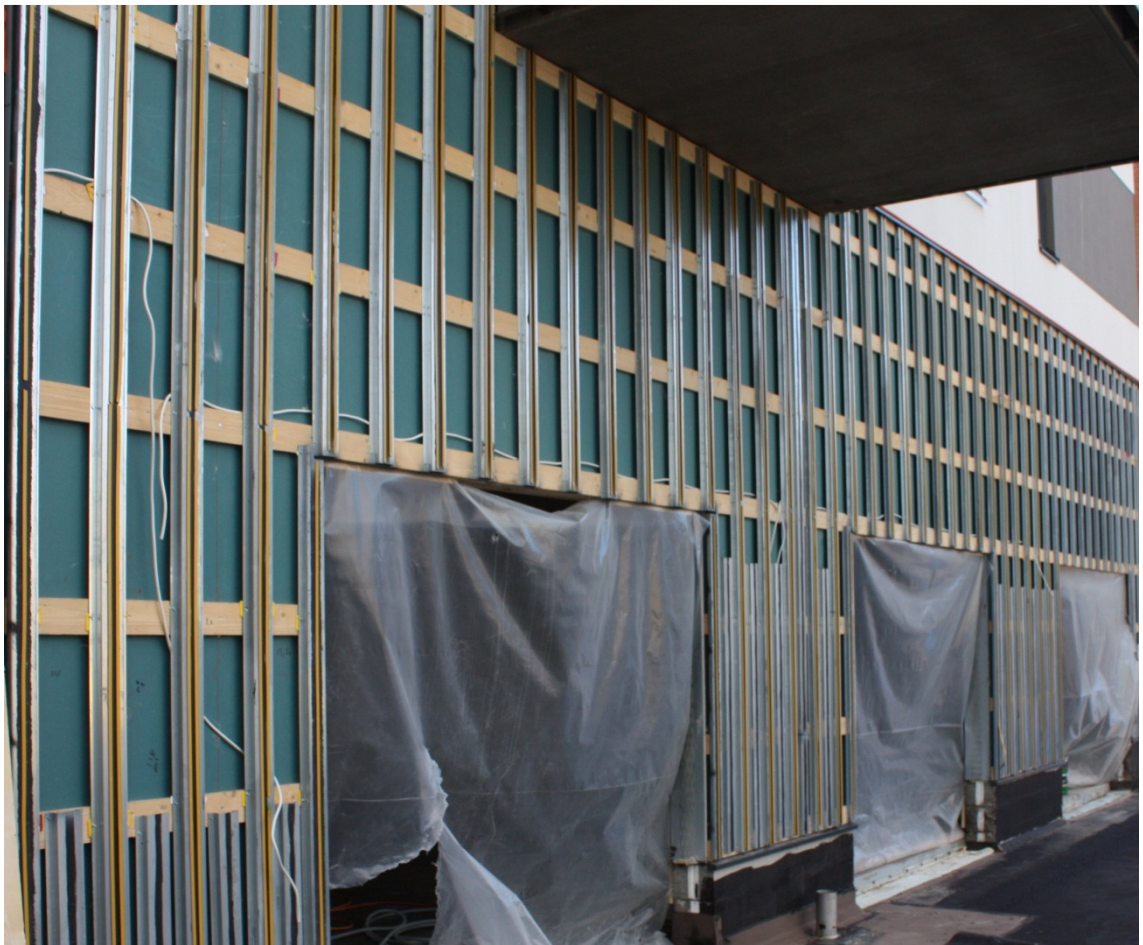
Kuva 3.7 StoneMate-järjestelmän hattuorsilla koolattu ulkoseinä
