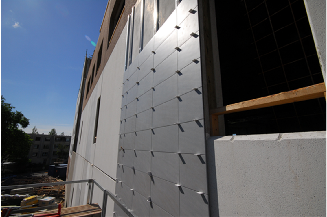
Kuva 6.6 StoneMate-järjestelmän hattuorsilla toteutettu laatoitus sandwichelementin pintaan Kauppakeskus Galleriassa Lappeenrannassa
