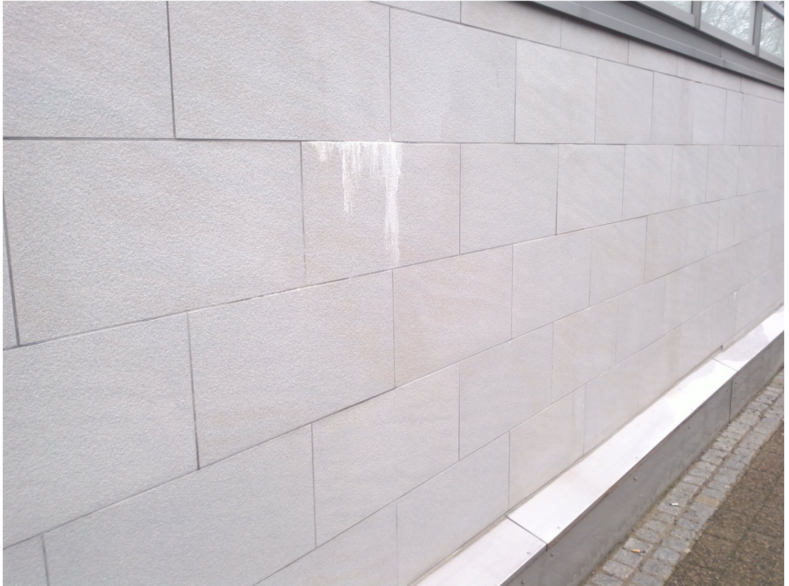
Kuva 6.8 Laastilla kiinnitetty julkisivulaatoitus Lappeenrannassa Kauppakeskus Galleriassa
