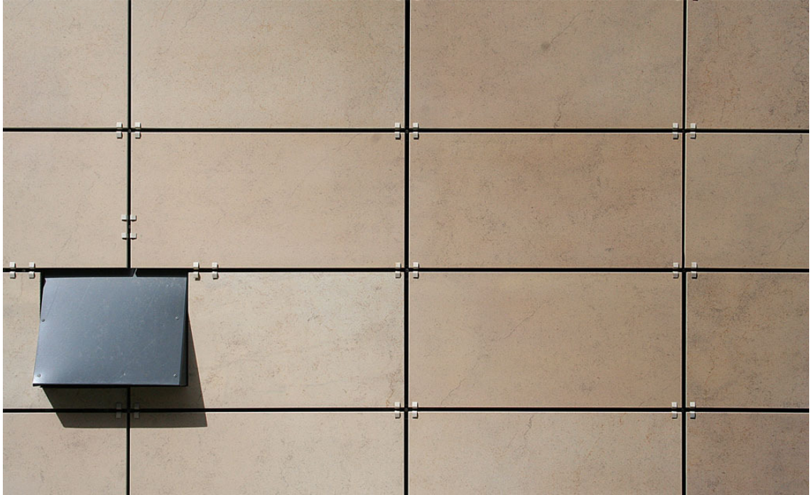
Kuva 6.4 Kaakelikeskusjärjestelmällä toteutettua julkisivua Nättinummen ostoskeskuksessa (Kaakelikeskus. Referenssit)
