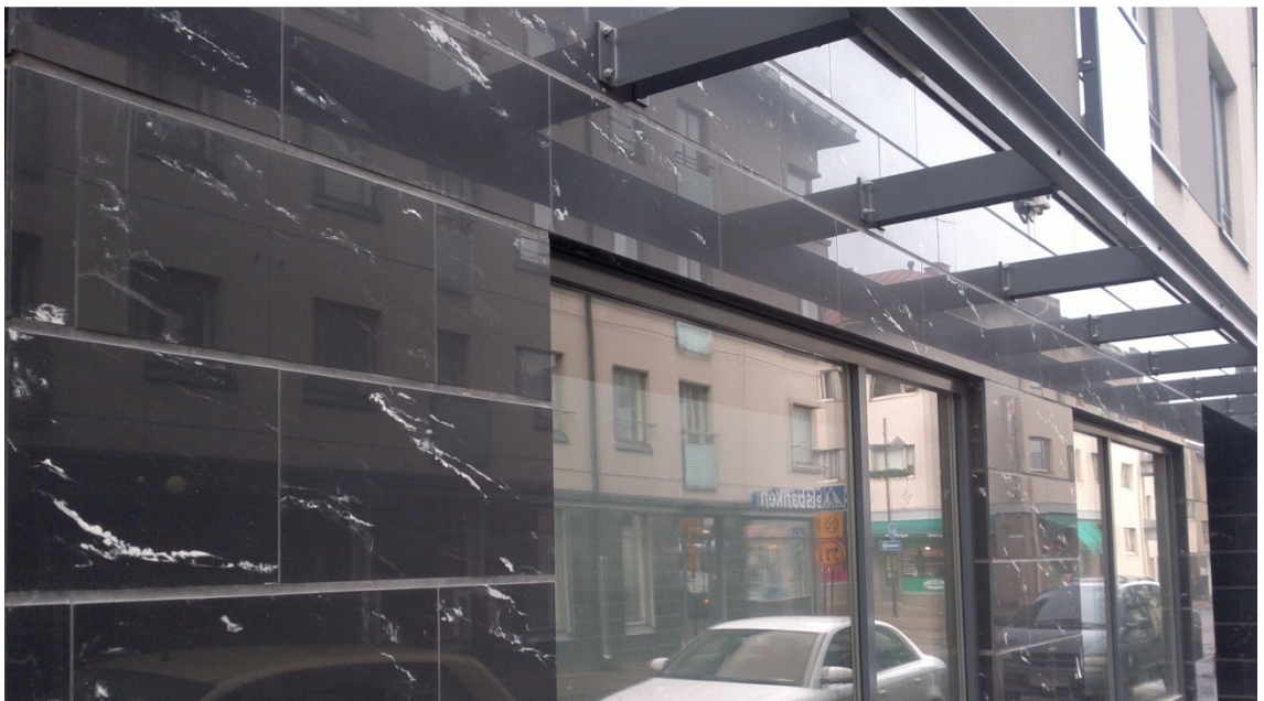
Kuva 6.9 Laastilla kiinnitetty julkisivulaatoitus Raatimiehenkadulla Lappeenrannassa
