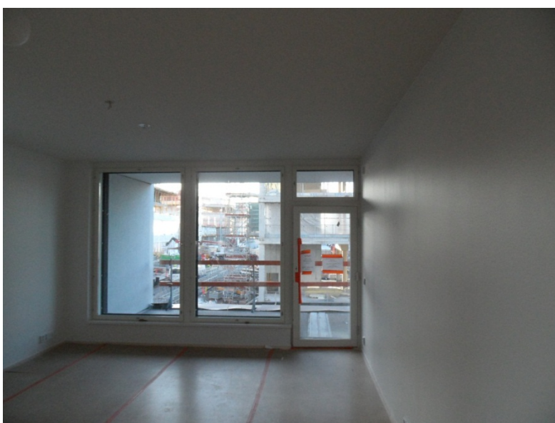
Kuva 3.5 Seinät, katto, ikkunat, parvekkeen ovi
