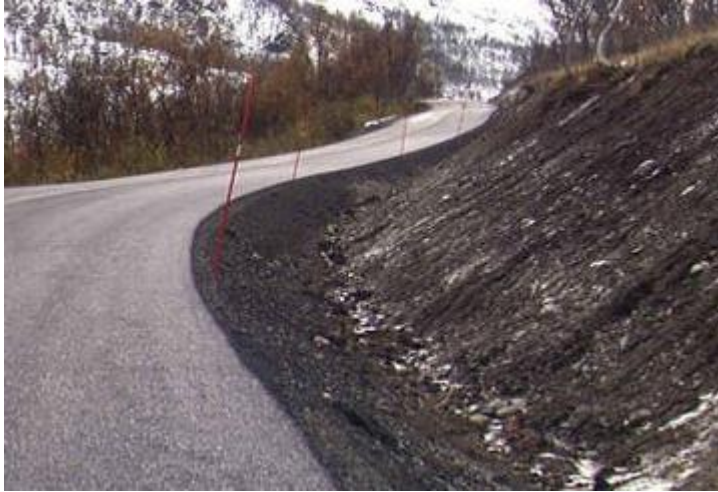
Kuvio 21. Perattu sivuoja (Roadex Implementing Accessibility 2001–2011b)
