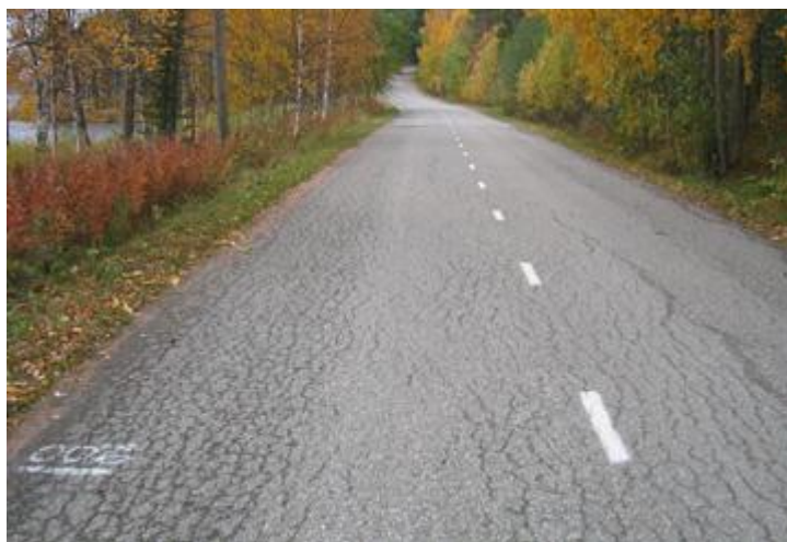
Kuvio 18. Verkkohalkeamaa päällystetyllä tiellä (Roadex Implementing Accessibility 2001–2011c)
