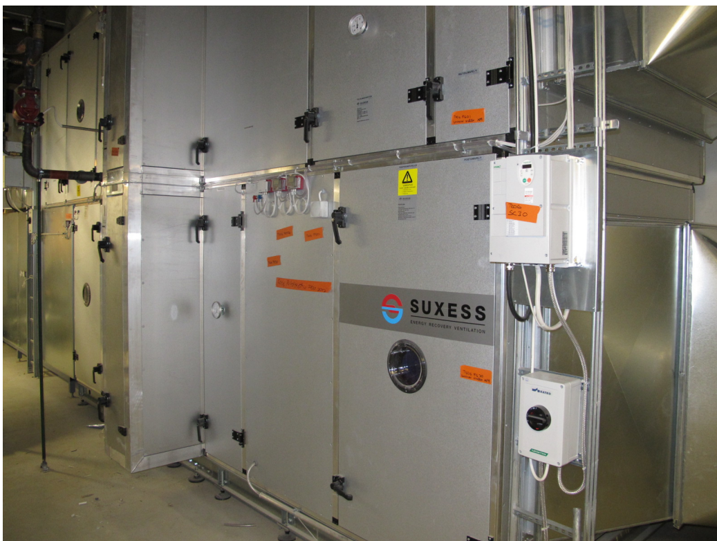
KUVA 3. Tulo- / Poistoilmakone lämmöntalteenottolaitteella varustettuna
