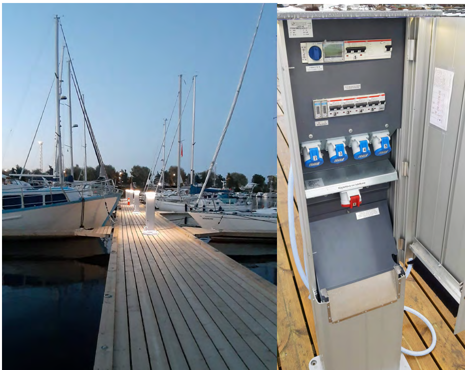
Kuvat 5 ja 6. Sapokan vierasvenelaiturin uudet sähkö-, vesi- ja valokalusteet. (Kuvat: Jussi Sutela)
