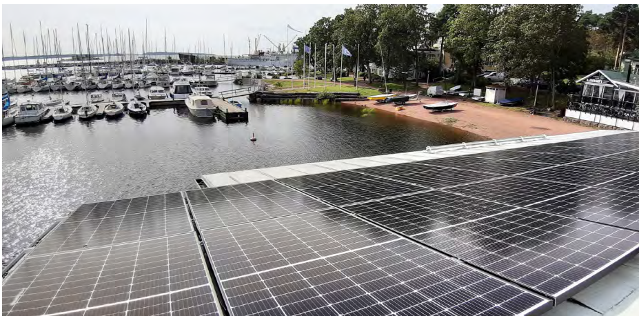
Kuva 7. Sapokan saunarakennuksen katon paneelikenttä. (Kuva: Jussi Sutela)
