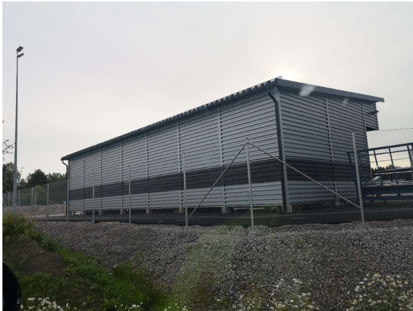
Kuva 21 Näkymä rakennuksen takaa.
