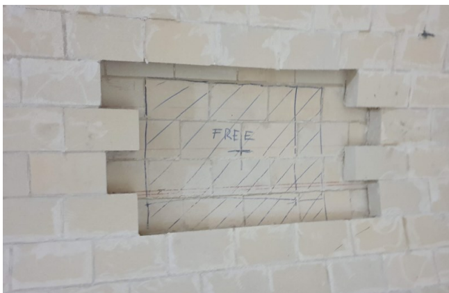
Kuva 2 Haponkestävien tiilien kerrokset
