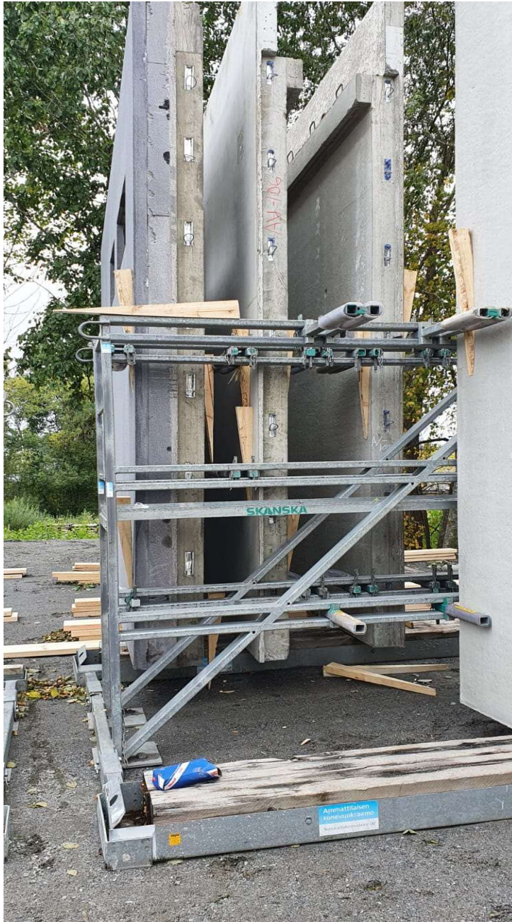
KUVA 20. Elementtivakki (Leskinen 2021.)
