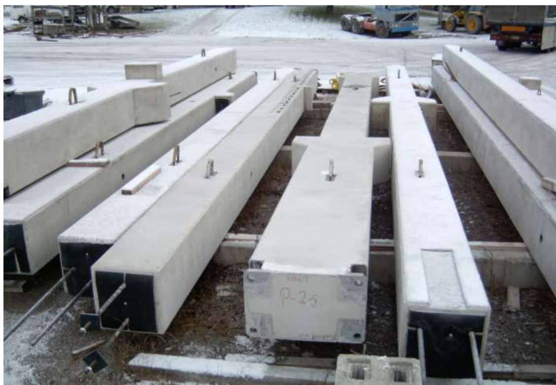
KUVA 3. Elementtipilarin varastointi (Elementtisuunnittelu 2020.)
