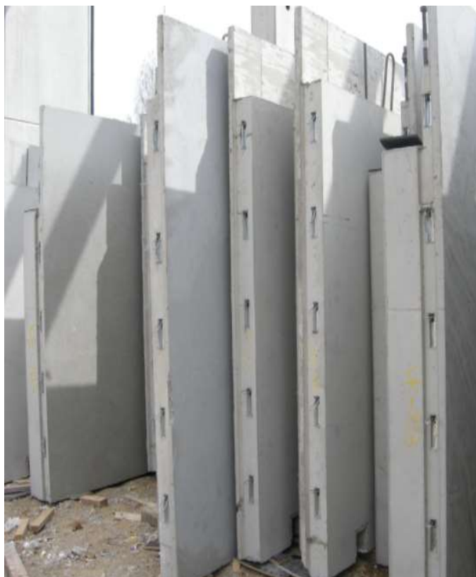
KUVA 19. Elementtiseinä (Elementtisuunnittelu 2020.)
