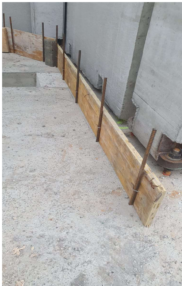
KUVA 23. Elementtien juurivalujen muotti (Leskinen 2021.)
