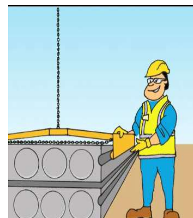
KUVA 29. Vaarnan kiinnitys (Ohje 2021.)
