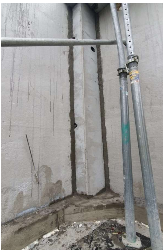
KUVA 24. Pystysaumapumppamalla tehdyt pystysaumot ja juurivalut (Leskinen 2021.)
