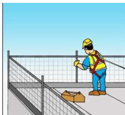
KUVA 33. Kaiteiden asennus (Ohje 2021.)
