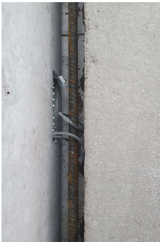
KUVA 22. 12 mm harjateräs seinäelementin ja pilarin välissä (Leskinen 2021.)
