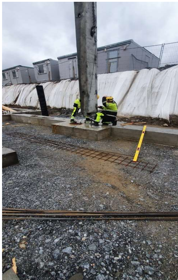
KUVA 4. Pilarin paikalle asentaminen (Leskinen 2021.)
