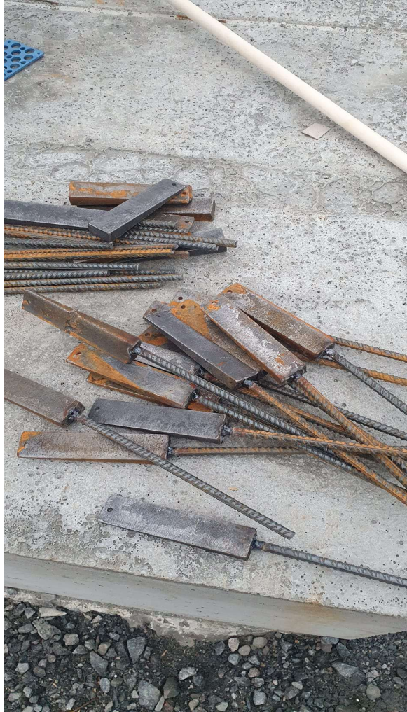
KUVA 16. Elementtipalkin kiinnityskiilat (Leskinen 2021.)
