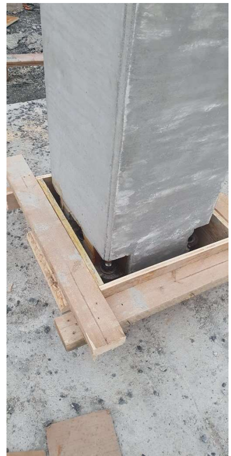
KUVA 9. Pilarimuotti (Leskinen 2021.)
